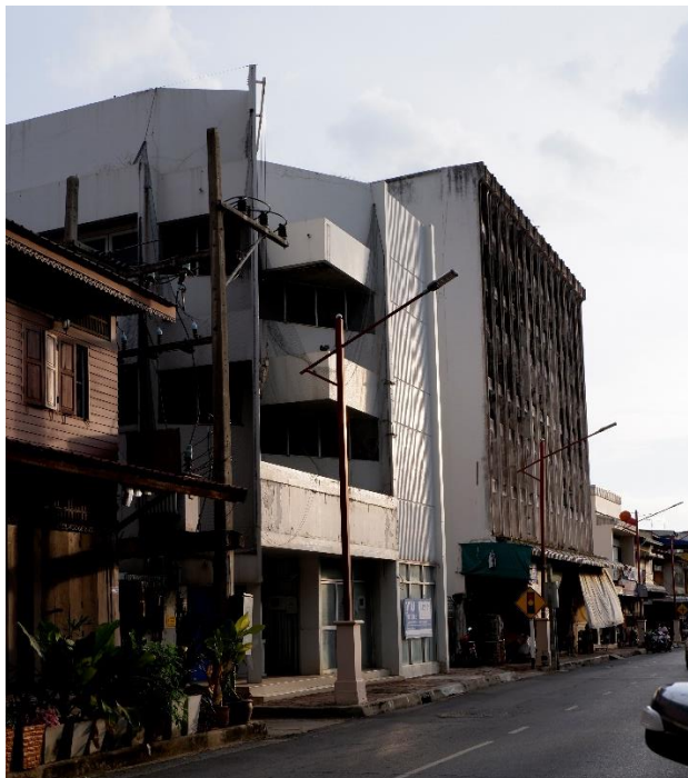
ภาพที่ 47 การสำรวจอาคารโมเดิร์นบนถนนอนันท์จินดา (สำรวจด้วยตัวผู้วิจัยคนเดียว)
