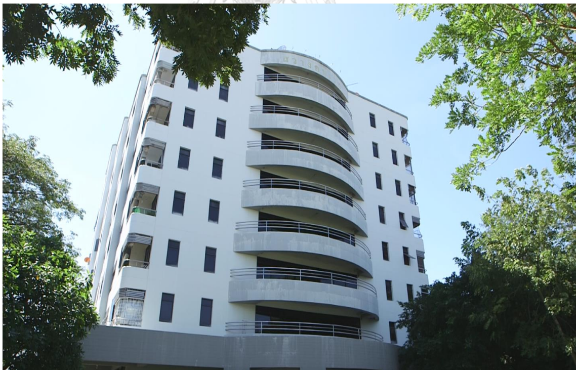
รูปที่ 4.7 บริเวณภายนอกอาคารโครงการสว่างคนใจ
