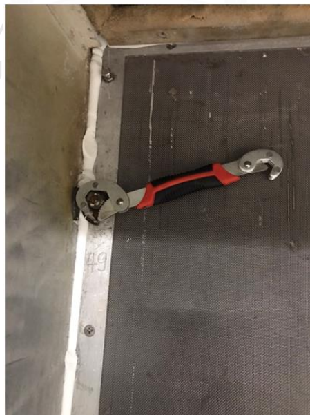
รูปที่ 4.3 ถอดตัวกรองลมโดยใช้ประแจ
