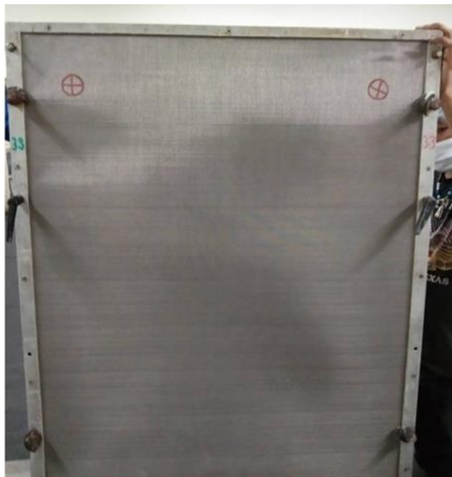
รูปที่ 5.2 เปลี่ยนหัวฉีด และรังผึ้งของตัวกรองลม
