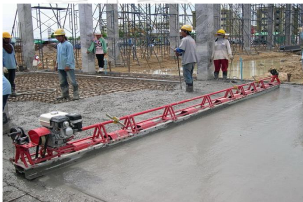
ภาพที่ 2.7 เครื่องปาดปูนอัตโนมัติ (Automation Concrete Screeding Machine)
