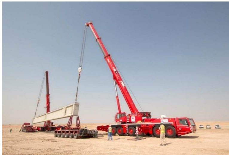
ภาพที่ 2.3 เครื่องจักรกล : รถเครนยกชิ้นส่วนระบบสำเร็จรูป (ที่มา: Terex Crane, 2018)
