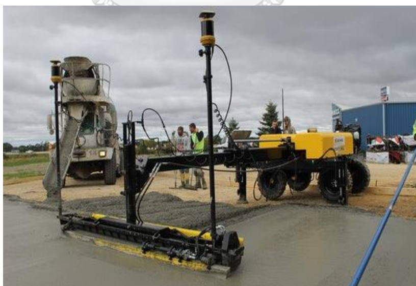
ภาพที่ 2.4 ระบบอัตโนมัติ : เครื่องปาดผิวหน้าคอนกรีตอัตโนมัติ (ที่มา: https://www.forconstructionpros.com/ , 2016)
