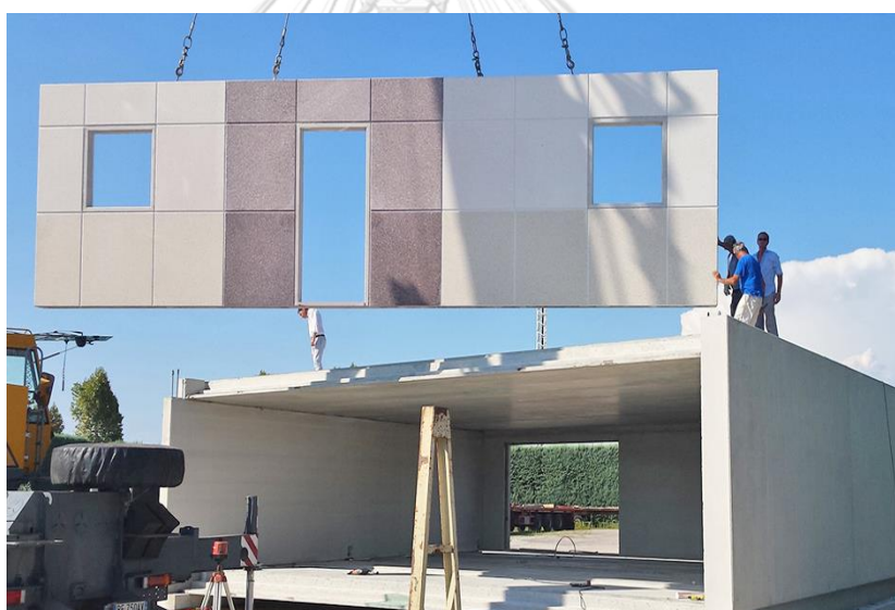
ภาพที่ 2.2 วิธีการก่อสร้างระบบชิ้นส่วนสำเร็จรูป : ประกอบผนังสำเร็จรูป (ที่มา: BFT International)
