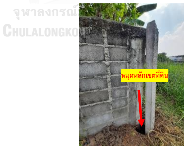
รูปที่ 5 ตัวอย่างหมุดหลักเขตที่ดินอยู่ใกล้กำแพงที่มีสภาพแวดล้อมเปิดโล่ง
