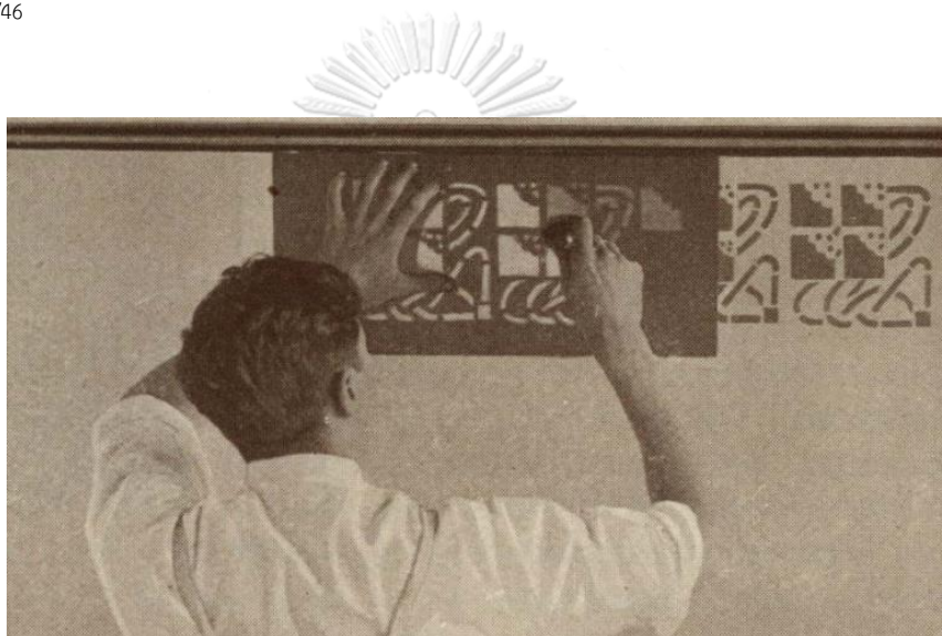
ภาพที่ 46 : แม่พิมพ์ขนาดเล็ก ช่างพิมพ์สามารถใช้มืออีกข้างหนึ่งที่ไม่ได้ถือพู่กันกดยึดแม่พิมพ์ไว้กับผนังได้
