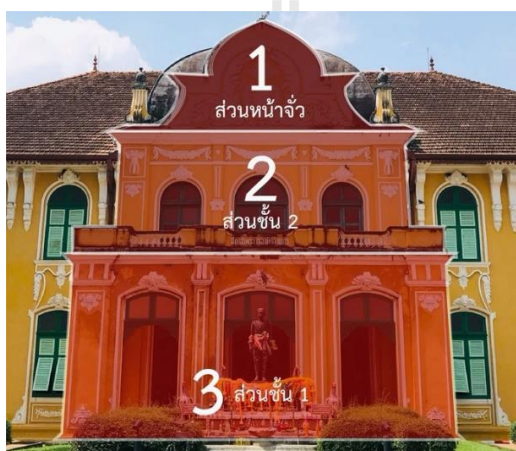
ภาพที่ 68 : พื้นที่ส่วนมุขด้านหน้าอาคารจะถูกแบ่งออกเป็น 3 ส่วน ได้แก่ 1. หน้าจั่ว 2. ชั้นสอง 3. ชั้นหนึ่ง
