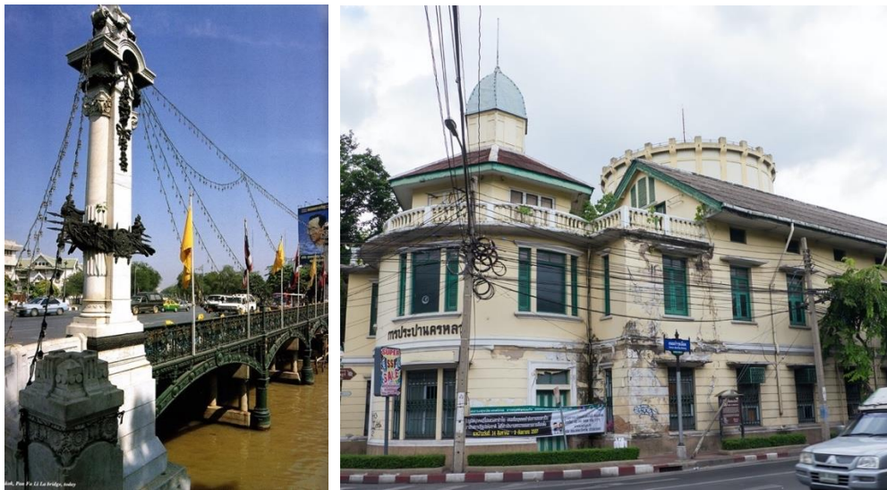
ภาพที่ 15 : (ภาพถ่าย) สะพานผ่านฟ้าลีลาศ ออกแบบโดยคาร์โล อัลเลกรี (Carlo Allegri) และก่อสร้างโดยบริษัทโฮวาร์ธเออร์สกิน จำกัด (Howarth Erskine & Co., Ltd.) (ภาพขวา) หอน้ำประปา ขนาด 40,000 แกลลอน ภายในโรงประปาแมนศรีก่อสร้างโดยบริษัทโฮวาร์ธเออร์สกิน จำกัด (Howarth Erskine & Co., Ltd.)
