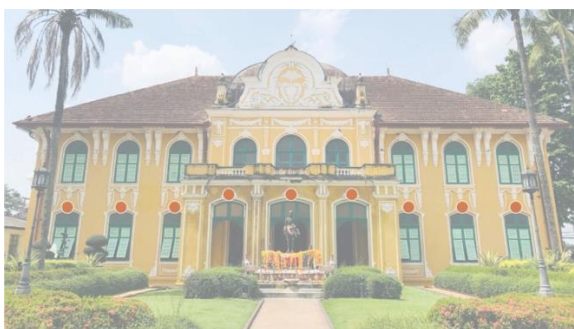
ภาพที่ 148 : Keystone ส่วนที่ 2 บริเวณยอดบนสุดของประตูและหน้าต่างรวมถึงช่องลมของอาคารชั้นหนึ่ง
