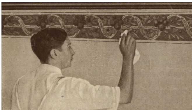
ภาพที่ 49 : การสร้างค่าน้ำหนักสว่างให้กับลวดลายด้วยการใช้ผ้าสะอาดเช็ดสีออก ที่มา: The Sherwin-Williams Co. / Stencils and stencil materials, (Cleveland, Ohio, The Sherwin-Williams Co. 2453) 5.
