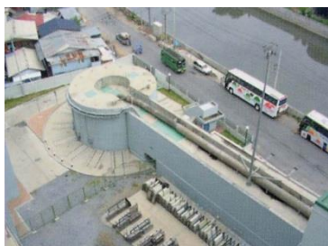
สถานีสูบน้ำเข้าระบบ
