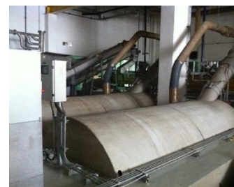
ตะแกรงดักขยะขนาดเล็ก
