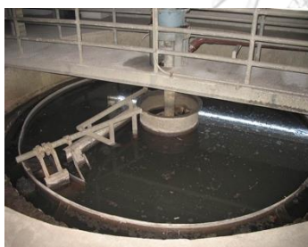
ถังเพิ่มความ เข้มข้นของตะกอน
