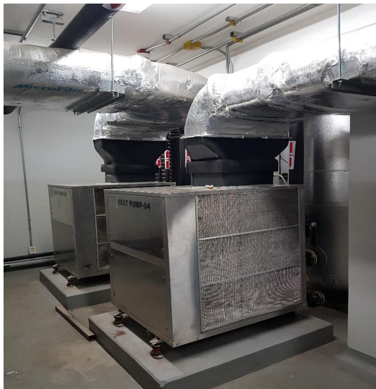
รูปที่ 2 ลักษณะของการติดตั้งของฮีทปั๊มจากพื้นที่ใช้งานจริงขนาด 25.05 kW
