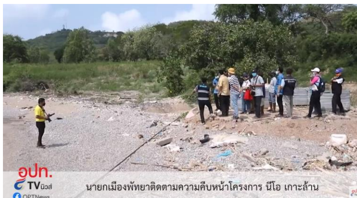
ภาพที่ 41 สถานที่สร้างท่าเรือ เกาะล้าน
