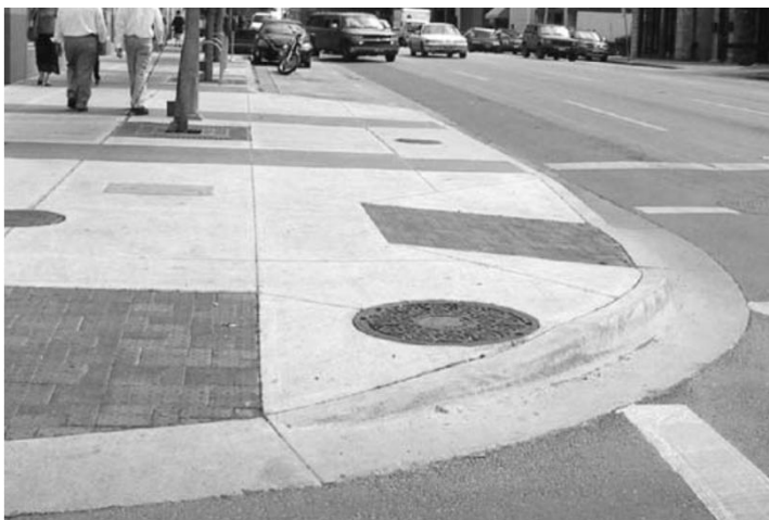
รูปที่ 2.5 การขยายขอบทางเดินริมถนน (Fitzpatrick et al., 2006)
