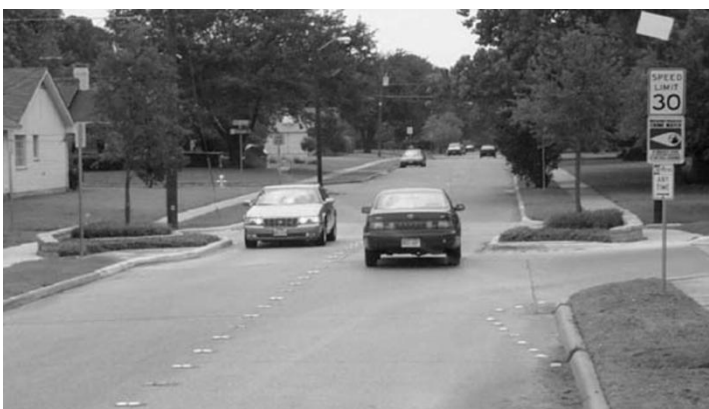
รูปที่ 2.6 การลดความกว้างของช่องจราจร (Fitzpatrick et al., 2006)
