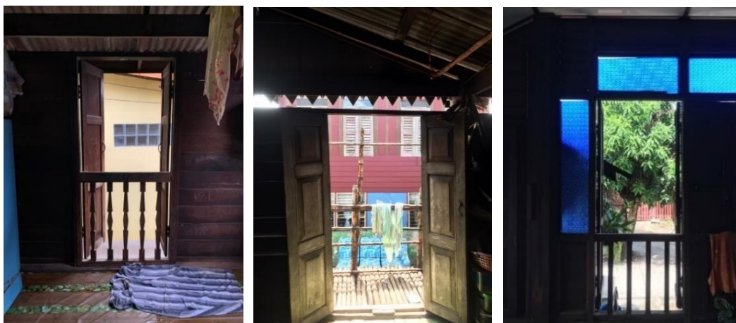
ภาพที่ 20 ภาพลักษณะของช่องหน้าต่างต่างพบในรูปแบบที่ 1 กลุ่มเรือนหลังคาทรงจั่วสูงหรือปีกนก (กลุ่มเรือนที่มีช่วงอายุมากกว่า 100 ปี)
