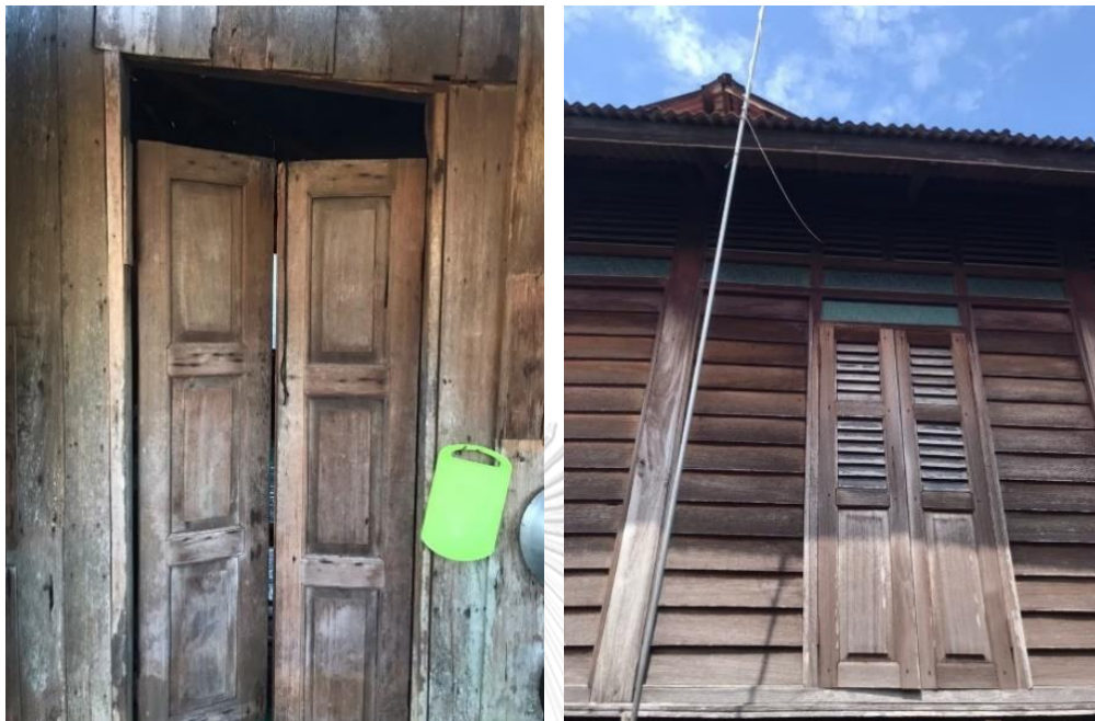
ภาพที่ 26 ลักษณะช่องเปิดของรูปแบบที่ 2 กลุ่มเรือนหลังคาทรงแปริ่ง (กลุ่มเรือนที่มีช่วงอายุที่ 80 - 100 ปี) ที่มา : ผู้วิจัย, 2565
