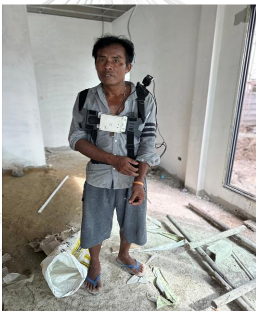
รูปที่ 5.16 รูปภาพแสดงแรงงานที่ติดตั้งเครื่องมือวัดปริมาณมลพิษทางอากาศและ เสียงส่วนบุคคล (กิจกรรมปูกระเบื้อง คนที่ 2)
