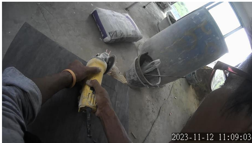
รูปที่ 5.18 รูปภาพแสดงกิจกรรมเจียรกระเบื้อง (โครงการกรณีศึกษาที่ 2)
