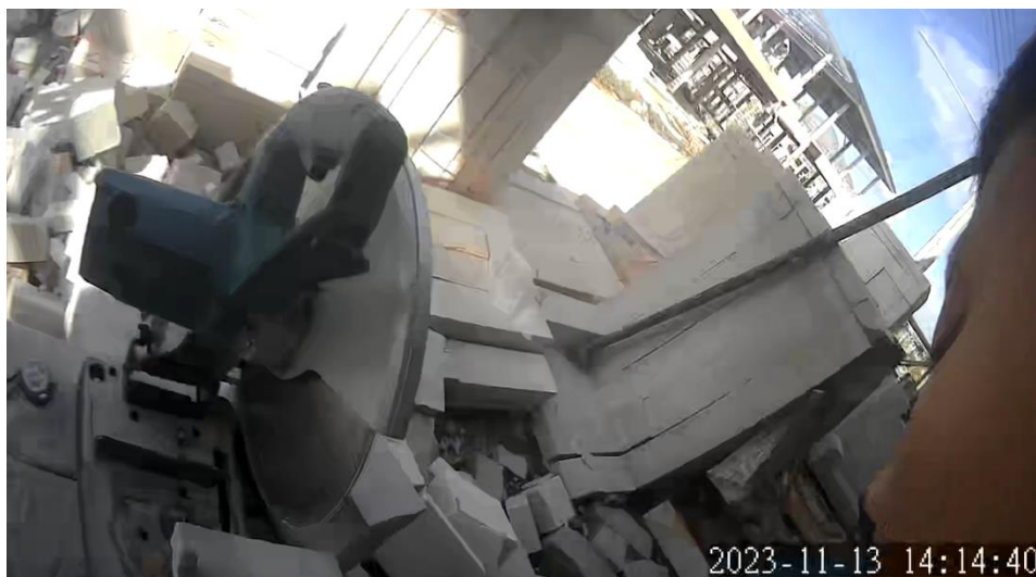
รูปที่ 5.24 รูปภาพแสดงกิจกรรมตัดอิฐมวลเบา (โครงการกรณีศึกษาที่ 2)
