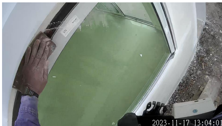
รูปที่ 5.34 รูปภาพแสดงกิจกรรมติดตั้งปูนสกินโค้ท (โครงการกรณีศึกษาที่ 3)
