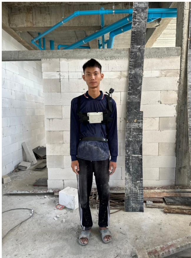
รูปที่ 5.22 รูปภาพแสดงแรงงานที่ติดตั้งเครื่องมือวัดปริมาณมลพิษทางอากาศและ เสียงส่วนบุคคล (กิจกรรมก่ออิฐมวลเบา คนที่ 2)
