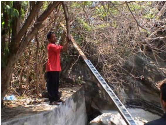
เตรียมติดตั้งไม้วัดระดับน้ำ (3)
