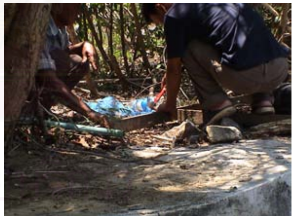
เตรียมติดตั้งไม้ค้ำยัน (2)
