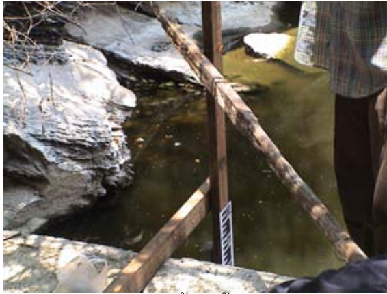
เตรียมติดตั้งไม้ค้ำยัน (3)
