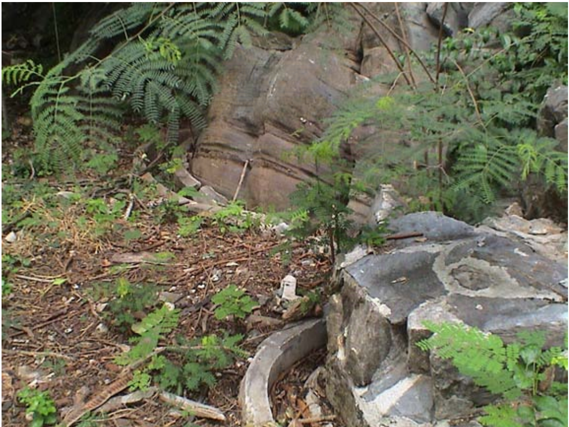
รูปที่ 5-3 แนวรางระบายน้ำบริเวณน้ำตก 8 ชั้น
