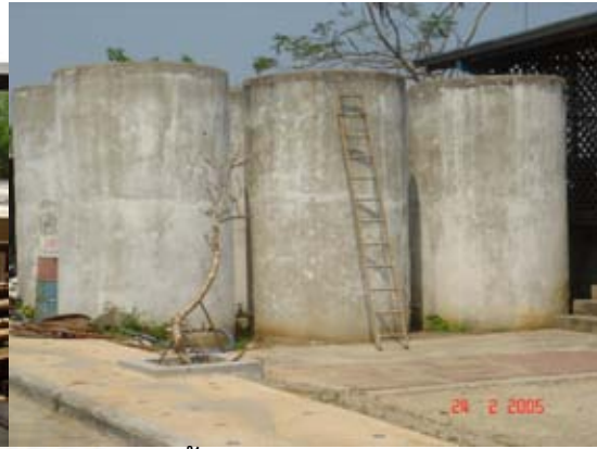
ถังเก็บน้ำกองทุนหมู่บ้าน
