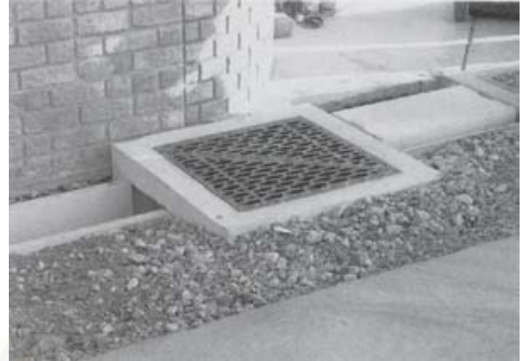
4.2 บ่อดักน้ำ
