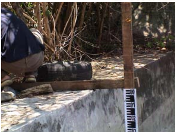
เตรียมติดตั้งไม้ค้ำยัน (1)
