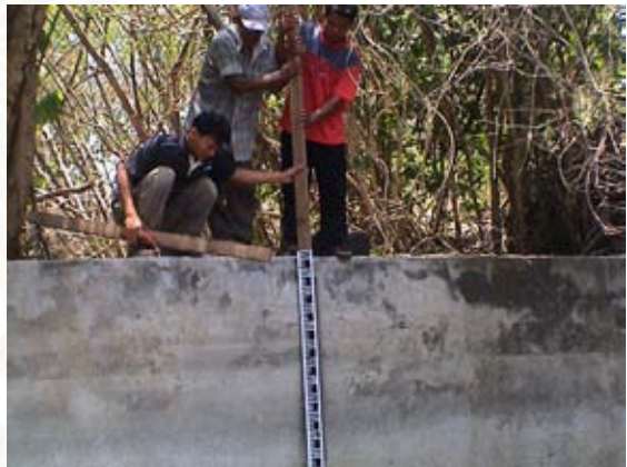
เตรียมติดตั้งไม้วัดระดับน้ำ (4)
