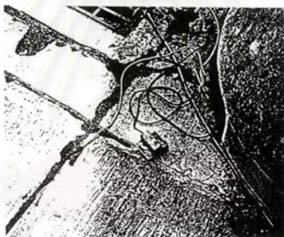
รูปที่ 5.6 การติดตั้งตัวตรวจวัดด้านที่ชิดกับเกาะ
