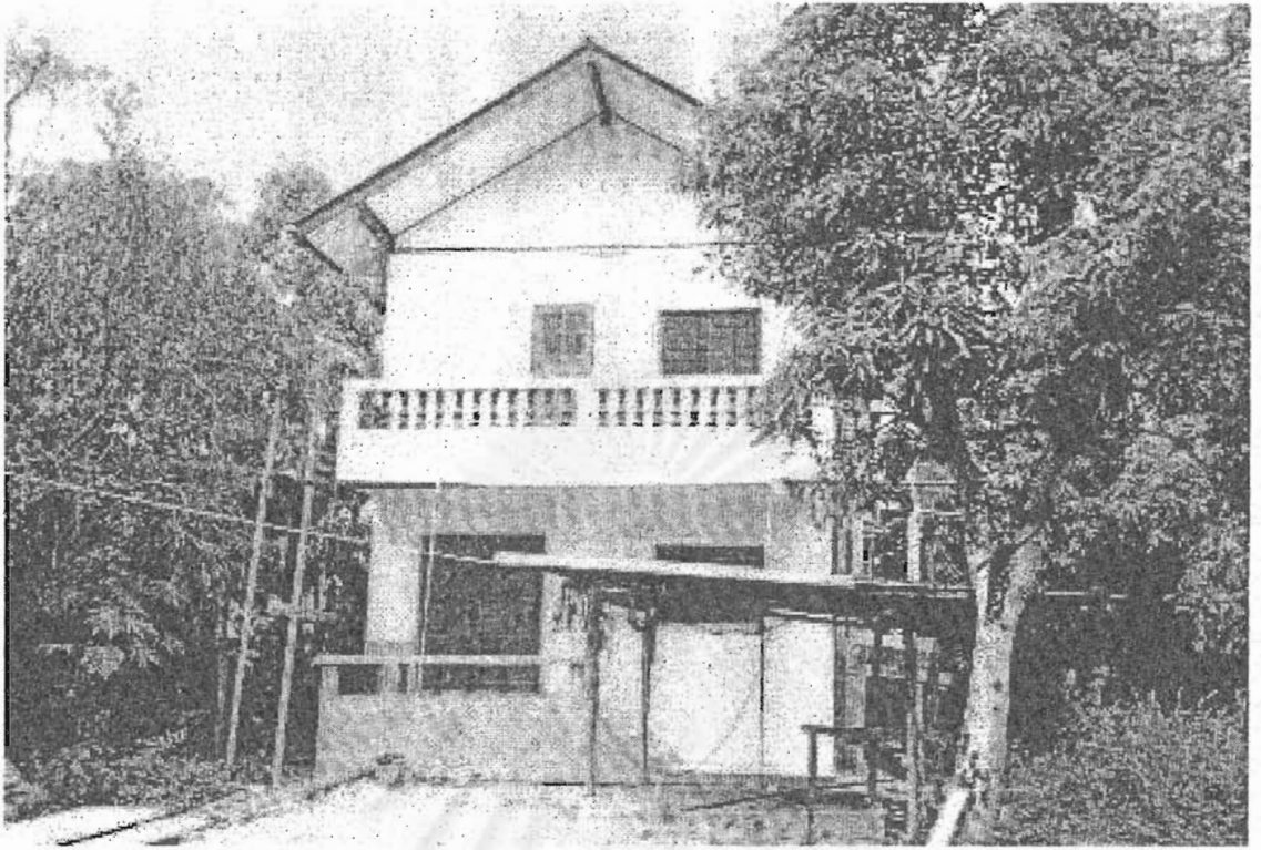
รูปที่ 5.3 รูปแบบบ้านที่กำลังเป็นที่นิยมก่อสร้างบนเกาะเกร็ด แต่ต้นทุนการก่อสร้างจะสูงเพราะการขนส่งวัสดุทำได้ยากลำบาก
