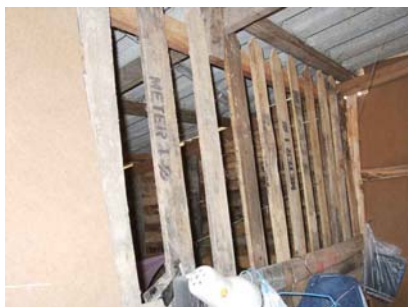
รูปที่ 5.7.6 แสดงการตีฝาเพื่อระบายอากาศ
