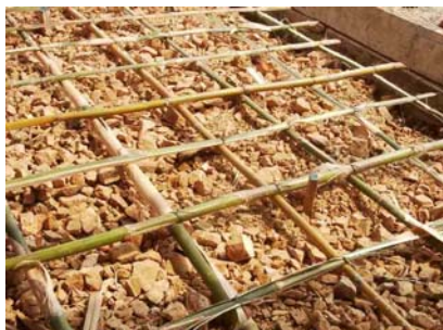
รูปที่ 5.15.9 แสดงการใช้ไม้ไผ่แทนเหล็กเสริมพื้น
