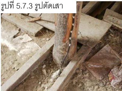
รูปที่ 5.7.4 แสดงการตีไม้ประกับเพื่อแก้ปัญหาบ้านทรุดตัว
