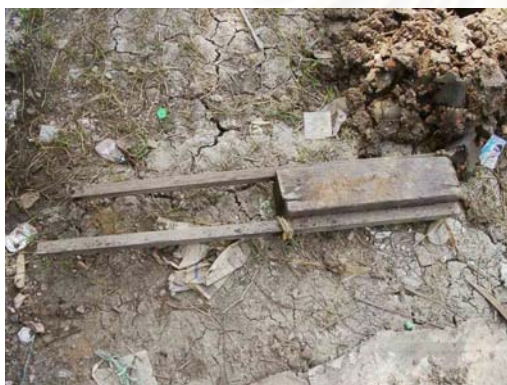
รูปที่ 4.42 แสดงเครื่องมือที่เอาไปบดอัดดินให้ แน่นก่อนการเทพื้น
