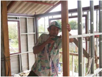
รูปที่ 5.3.14 ภาพแสดงการต่อโครงคร่าวเหล็กผนังชั้นบน
