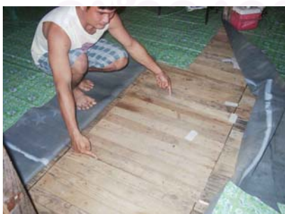
รูปที่ 5.13.5 แสดงการปูพื้นโดยใช้ไม้จริงทั้งแผ่น
