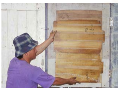
รูปที่ 5.12.11 แสดงการใช้ไม้ที่เอาไว้ใส่โชว์ เลือกขายนำมาต่อเป็นหน้าต่าง
