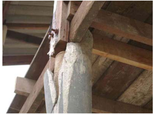
รูปที่ 4.59 แสดงการแตกของเสาที่ใช้ท่อซีเมนต์ใย หินในการหล่อเสา
