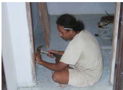
รูปที่ 5.6.10 แสดงการติดตั้งประตู
