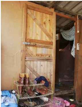
รูปที่ 5.7.11 ประตูบ้านที่ทำจากรังไม้ที่เก็บได้
