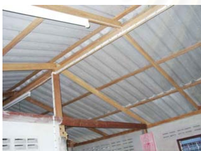
รูปที่ 5.18.12 แสดงโครงหลังคา
