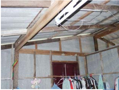
รูปที่ 5.17.12 แสดงโครงหลังคา
