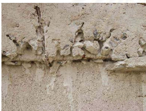
รูปที่ 4.54 แสดงสภาพปูนที่หล่อไม่เต็มแบบ เนื่องจากต้องการประหยัดจึงใส่หินมาก
