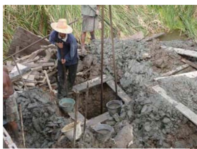
รูปที่ 5.16.5 แสดงการขุดดินเสาเข็ม
