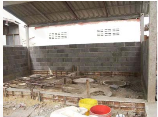
รูปที่ 4.61 แสดงผนังที่ไม่มีเสาเอ็น ทับหลัง แต่ หรือไม่มีเสริมเหล็กยึดกับเสา
