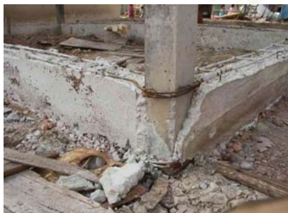
รูปที่ 5.8.7 แสดงการล้อมเสาของเหล็กเสริมคาน
