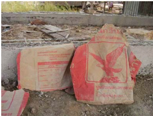
รูปที่ 4.60 แสดงปูนที่ใช้หล่อในส่วนโครงสร้างมักจะ ใช้ปูนชนิดสำหรับการฉาบเพราะต้องการประหยัด
