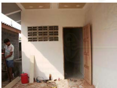
รูปที่ 5.6.8 แสดงผนังภายในใช้ปูนซีเมนต์ขาวฉาบ
