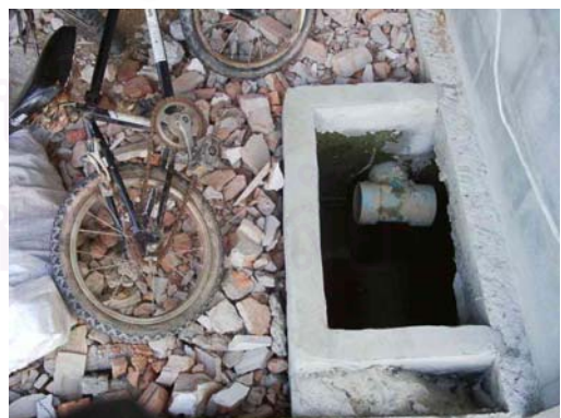
รูปที่ 4.63 แสดงการรังวัดที่ผิดพลาดทำให้บ่อพัก น้ำเสียของส่วนกลางเข้าไปอยู่ในตัวบ้าน
