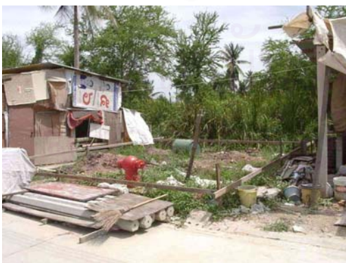
รูปที่ 4.62 แสดงหัวจ่ายน้ำดับเพลิงล้ำเข้าไปใน ที่ดินของชาวบ้าน
