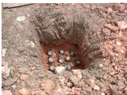
รูปที่ 5.1.4 แสดงการเสริมขดเบียร์ในฐานราก
