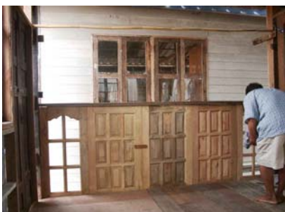
รูปที่ 5.9.10 แสดงการติดตั้งภายในด้วยหน้าต่างไม้
