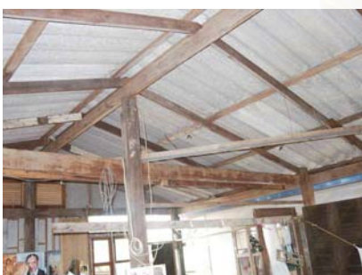
รูปที่ 5.9.11 แสดงโครงหลังคา
