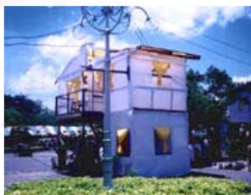
รูปที่ 4.69 แสดงบ้านตัวอย่างมาตรา 1:1 ที่ชาวบ้านร่วมกันสร้างใช้วัสดุกระดาษไม้ 1.5"x3" และผ้าฝ้ายดิบ
