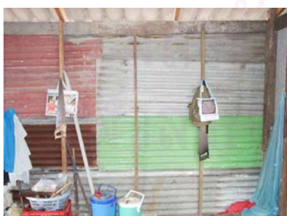
รูปที่ 5.2.8 แสดงผนังภายในชั้นบน
