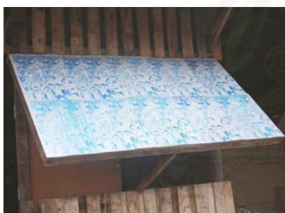
รูปที่ 5.13.8 แสดงการใช้สติ๊กเกอร์เคลือบ เงาติดหน้าต่างภายนอกเพื่อนกันไม้ผุ
