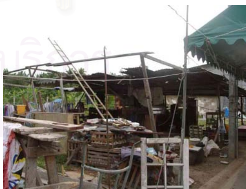
รูปที่ 4.26 แสดงบ้านที่สร้างชั่วคราวก่อนที่จะสร้างบ้านเสร็จ
