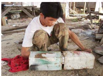
รูปที่ 5.11.9 แสดงการต่อปับทำแบบหล่อเสา
