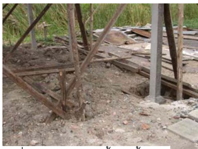
รูปที่ 5.4.5 แสดงการตั้งเสาชั้น 1
