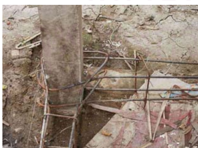
รูปที่ 5.3.9 แสดงการผูกเหล็กคานอ้อมเสา
