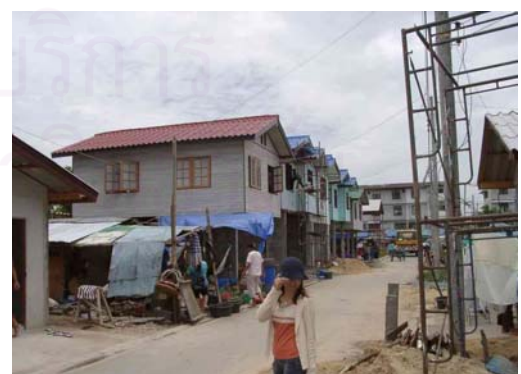
รูปที่ 4.39 แสดงบ้านที่กำลังก่อสร้างเพื่อให้เสร็จ ก่อนหน้าฝน
