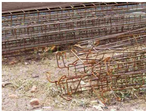
รูปที่ 4.47 แสดงเหล็กเสริมที่เตรียมไว้ก่อนการก่อสร้าง
