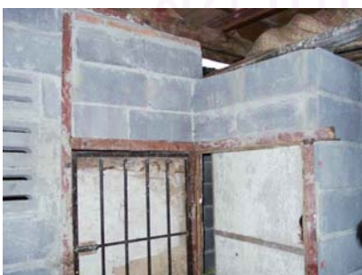
รูปที่ 5.5.9 แสดงการใช้เหล็กฉากแทนวงกบไม้ และแทนเสาเอ็น ทับหลัง
