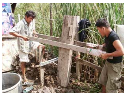
รูปที่ 5.3.5 แสดงการตอกเสาเข็มด้วยสองเกลอ
