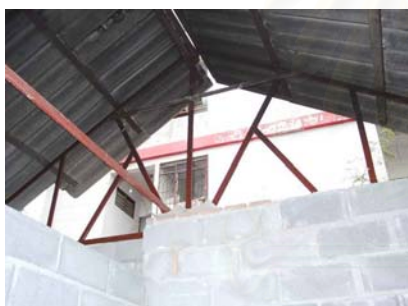
รูปที่ 5.12.12 แสดงโครงหลังคา
