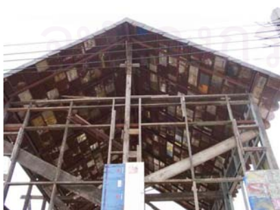
รูปที่ 5.11.13 แสดงโครงหลังคา และการมุง หลังคาด้วยปิป
