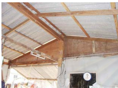
รูปที่ 5.14.9 แสดงโครงหลังคา
