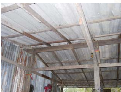
รูปที่ 5.1.10 แสดงโครงหลังคา
