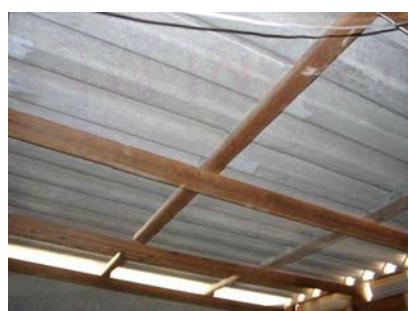
รูปที่ 5.8.12 แสดงโครงหลังคา
