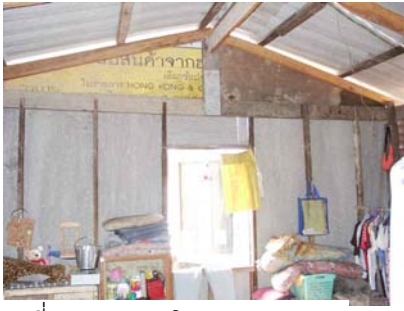
รูปที่ 5.2.9 แสดงโครงหลังคา
