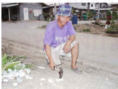
รูปที่ 5.12.9 แสดงการทุบหินอ่อนเพื่อใช้ผสมปูนแทนการใช้หิน
