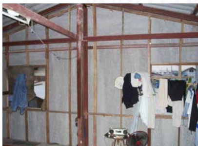
รูปที่ 5.5.13ภาพแสดงโครงสร้างเหล็กชั้นบน
