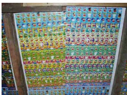
รูปที่ 5.13.9 แสดงการใช้สติ๊กเกอร์ธรรม ดาติดหน้าต่างภายในเพื่อนกันไม้ผุ
