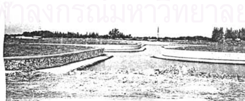
รูปที่ 5.6 พื้นที่ป่าชายเลนที่ถูกแทนที่ด้วยสิ่งปลูกสร้างริมน้ำ
