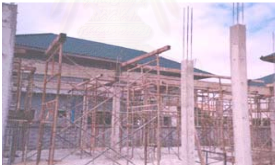
ภาพที่ 5.19 แสดงการติดตั้งนั่งร้านเพื่อรองการติดตั้งคานสำเร็จรูป
