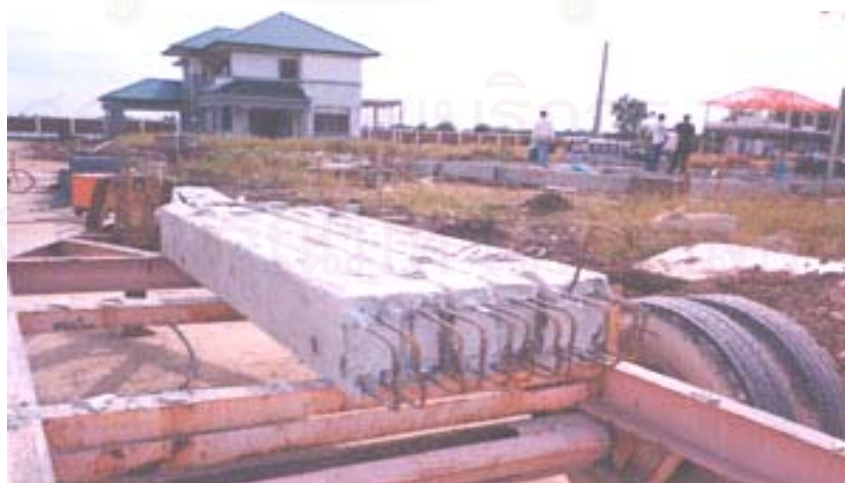
ภาพที่ 5.5 แสดงรถที่ใช้ขนคานสำเร็จรูปเพื่อเตรียมประกอบติดตั้ง
