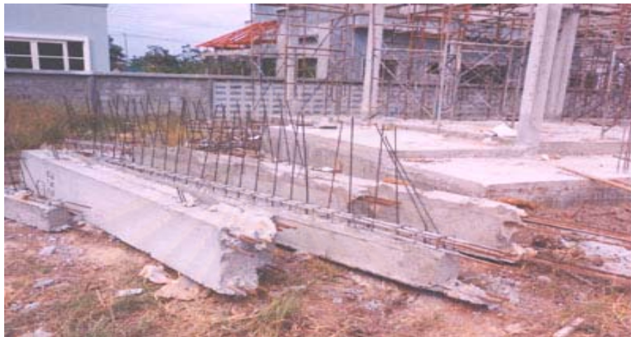
ภาพที่ 5.17 แสดงคานสำเร็จรูปขนส่งมาที่สถานที่ก่อสร้างเพื่อรอการประกอบติดตั้ง
