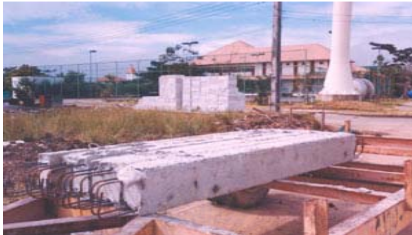
ภาพที่ 5.25 แสดงการขนย้ายเสาสำเร็จรูปจากโรงงาน
