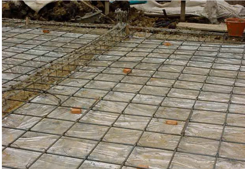
ภาพที่ 5.15 แสดงการวางเหล็กพื้นห้องน้ำ
