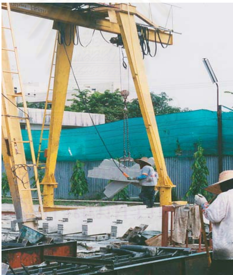
ภาพที่ 5.2 แสดงการใช้ Granty crane ยกชิ้นส่วนสำเร็จรูปหลังจากถอดแม่พิมพ์
