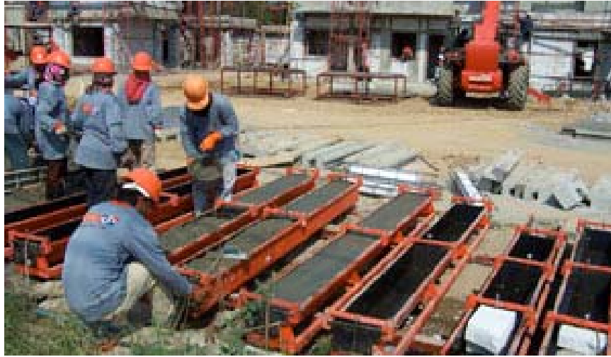
ภาพที่ 5.11 แสดงการเทคอนกรีตลงสู่แบบแม่พิมพ์
