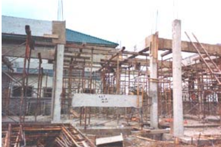
ภาพที่ 5.23 แสดงการติดตั้งคานสำเร็จรูปในส่วนชานพักบันได
