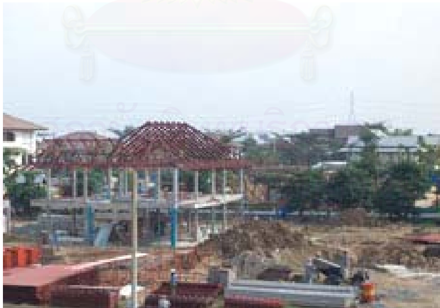
ภาพที่ 5.31 แสดงด้านหน้าการวางเสาเหล็ก 2C 150x50x3.2 ม.ม.
