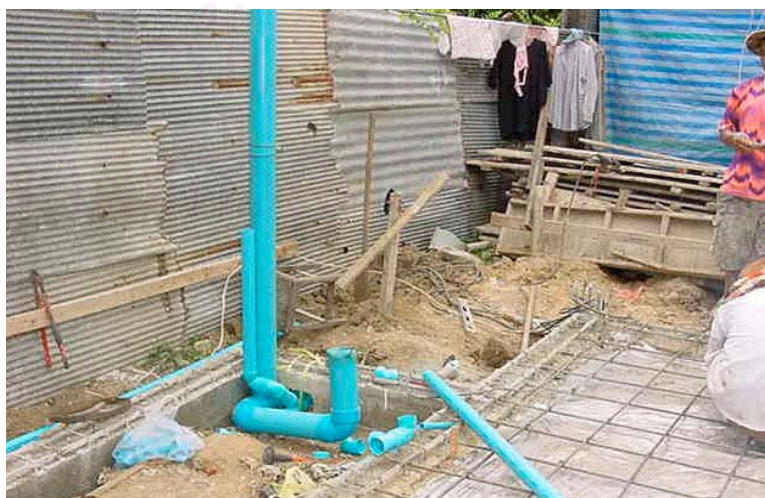
ภาพที่ 5.16 แสดงการวางท่อระบบประปาก่อนเทคอนกรีตพื้น
