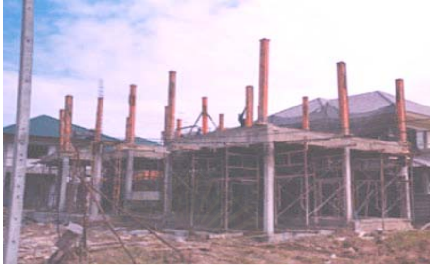
ภาพที่ 5.27 แสดงการติดตั้งเสาสำเร็จรูปในชั้นที่ 2
