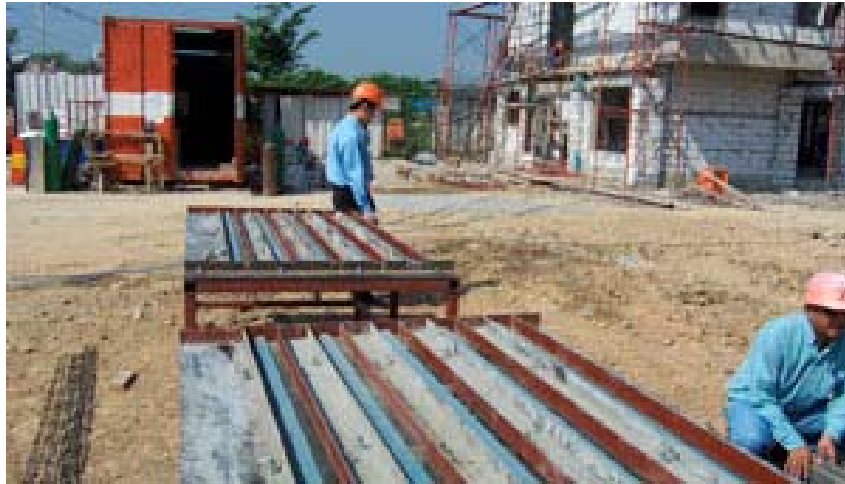
ภาพที่ 5.9 แสดงแบบแม่พิมพ์ขณะเตรียมหล่อคอนกรีต
