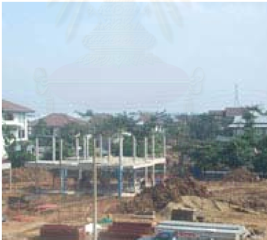
ภาพที่ 5.28 แสดงการติดตั้งเสาสำเร็จรูปในชั้นที่ 2 เตรียมประกอบโครงสร้างหลังคา
