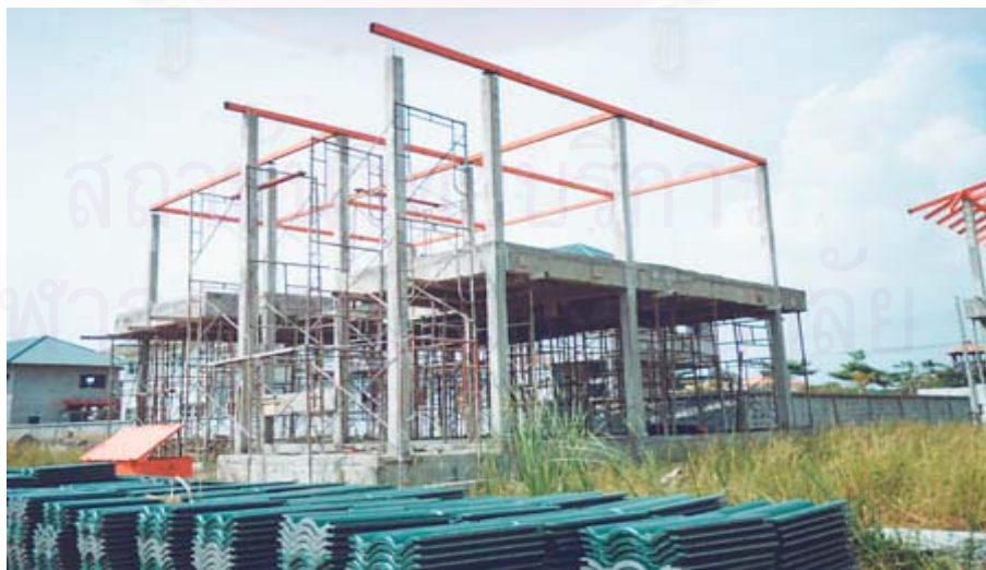
ภาพที่ 5.30 แสดงการวางอะเสเหล็ก ก่อนประกอบโครงสร้างหลังคา
