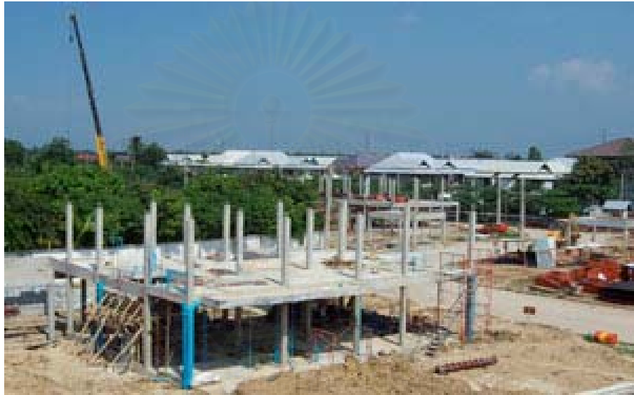
ภาพที่ 5.29 แสดงโครงสร้างสำเร็จรูปเมื่อถอดค้ำยัน
