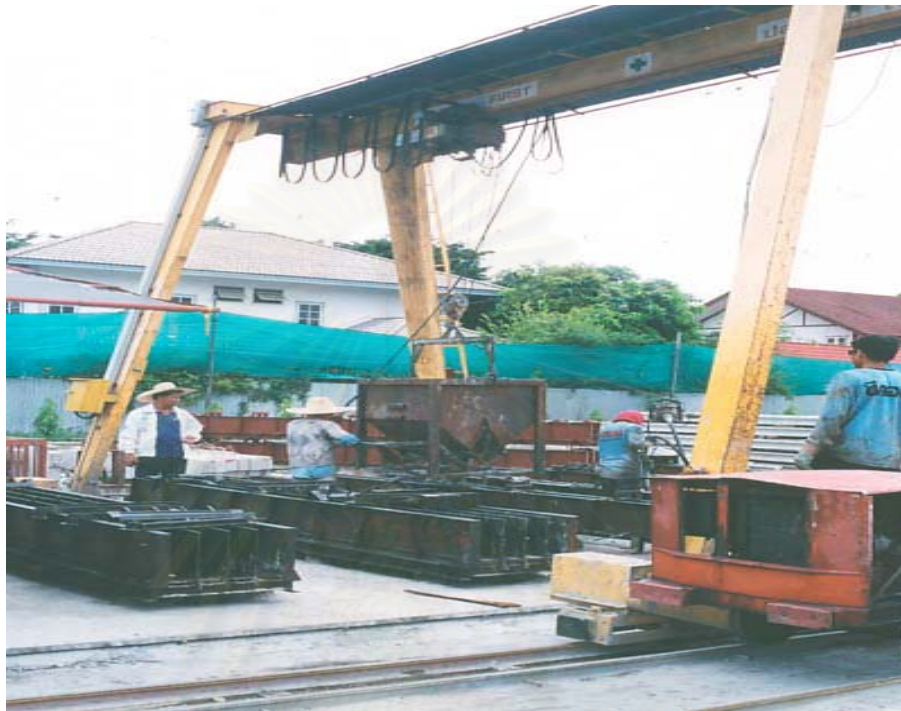
ภาพที่ 5.1 แสดงเครน Gantry crane ที่ใช้หล่อเสาคานสำเร็จรูป
