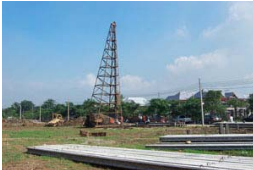
ภาพที่ 5.13 แสดงปั้นจั่นตอกเสาเข็มภายในโครงการ
