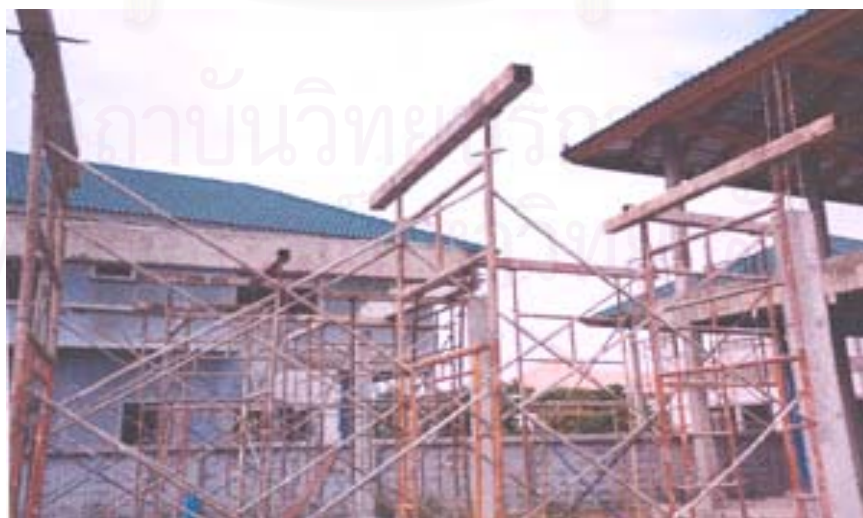
ภาพที่ 5.24 แสดงการติดตั้งคานสำเร็จรูปในชั้นที่ 2
