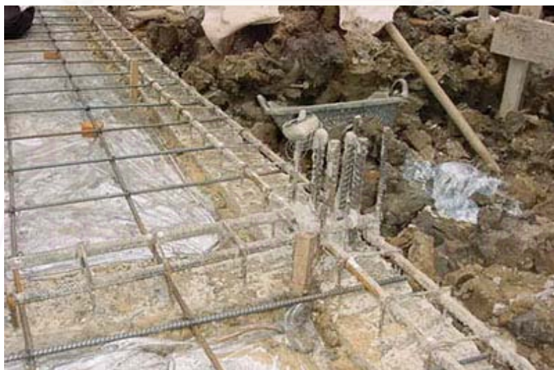
ภาพที่ 5.14 แสดงการวางตำแหน่งของคานในส่วนเตรียมพื้นหล่อในที่
