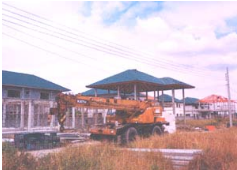
ภาพที่ 5.4 แสดงรถเครนล้อยางที่ใช้ประกอบติดตั้งเสา-คานสำเร็จรูป
