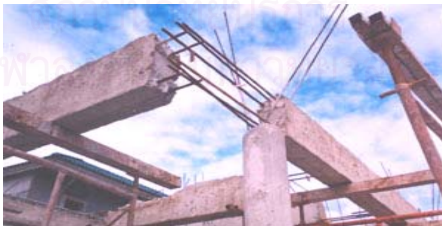
ภาพที่ 5.21 แสดงการติดตั้งคานสำเร็จรูปในส่วนที่มีการยื่น
