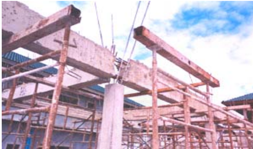
ภาพที่ 5.20 แสดงรอยต่อของเสา-คานสำเร็จรูป
