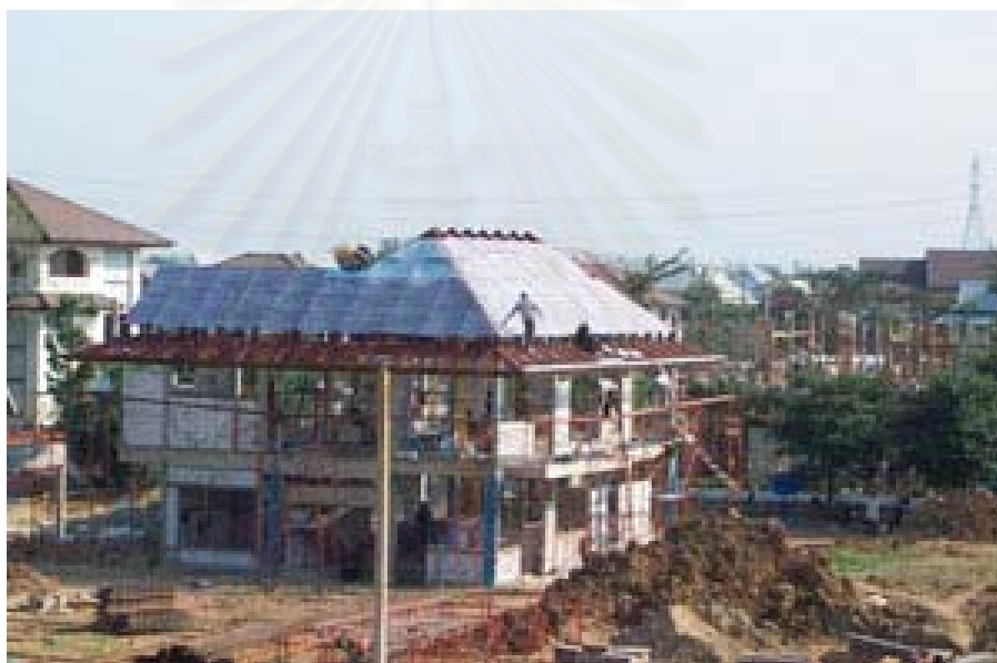
ภาพที่ 5.33 แสดงการมุงฉนวนกันความร้อนหลังคากับการก่อส่วนผนัง
