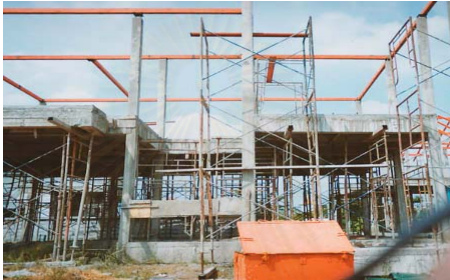
ภาพที่ 5.31 แสดงด้านหน้าการวางเสาเหล็ก 2C 150x50x3.2 ม.ม.
