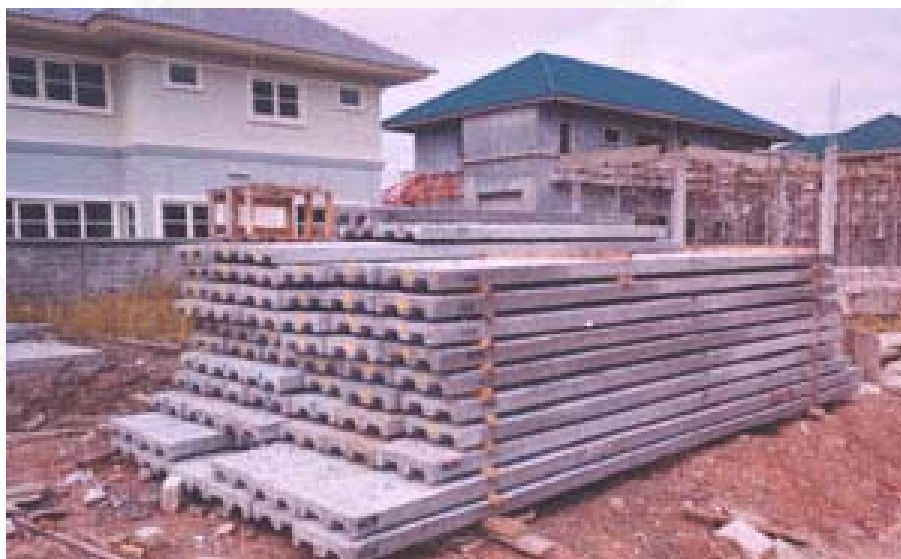
ภาพที่ 5.26 แสดงพื้นสำเร็จรูปซื้อจากผู้ประกอบการโรงงานสำเร็จรูป
