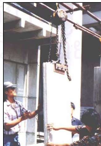
ภาพที่ 4.24 แสดงเครื่องช่วยยกแผ่นผนังขึ้นติดตั้ง
