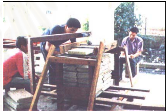
ภาพที่ 4.62 แสดงการทดสอบการรับกำลังคอนกรีต
