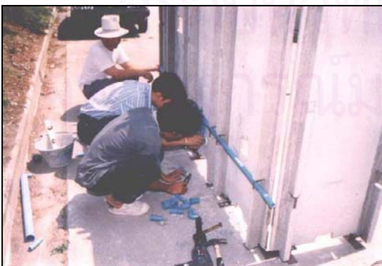
ภาพที่ 4.41 แสดงการเดินท่อประปา - ระบายน้ำ ผ่านช่องเดินท่อที่เตรียมไว้
