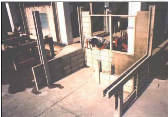
ภาพที่ 4.67 แสดงการทดลองติดตั้งเสา - คานสำหรับอาคารขนาดเล็กร่วมกับบล็อกและวงกบสำเร็จรูปในระยะแรก
