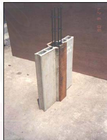
ภาพที่ 4.10 แสดงการติดตั้งแผ่นเสา 2 แผ่น
