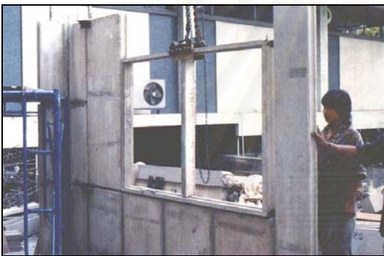
ภาพที่ 4.27 แสดงการติดตั้งวงกบ คสล.ที่ประกอบจากข้างล่างก่อนยกติดตั้ง
