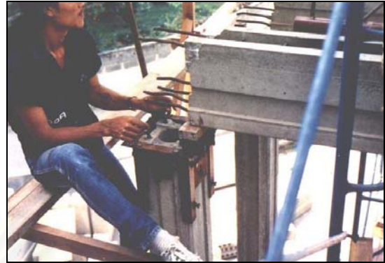
ภาพที่ 4.78 แสดงการใช้เครื่องช่วยในการประกอบคานกับเสา
