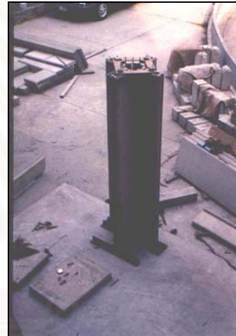
ภาพที่ 4.16 แสดงการติดตั้งแผ่นเสาสูง 2.40 ม. โดยใช้อุปกรณ์เครื่องช่วยด้านล่างและด้านบน
