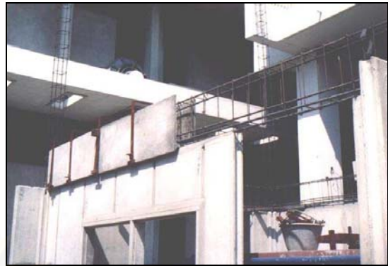
ภาพที่ 4.26 แสดงการติดตั้งแบบหล่อคานเพอร์โฟเรซีเมนต์ บนแผ่นผนังกลางที่ติดตั้งเสร็จแล้ว
