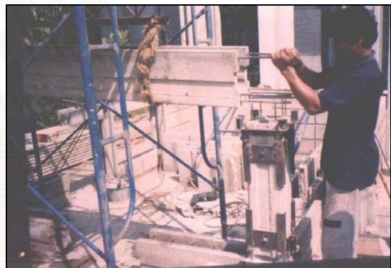
ภาพที่ 4.68 แสดงการเริ่มยกคานขึ้นติดตั้งบนหัวเสาที่ชั้นแรก โดยใช้เครื่องช่วยยกขนาดเล็กทั่วไป
