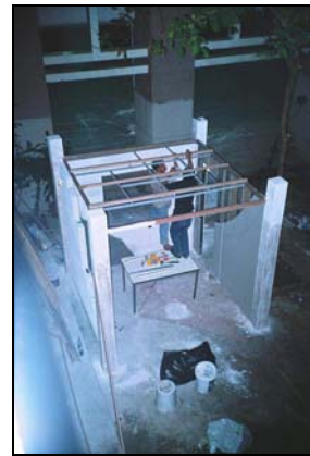
ภาพที่ 4.102 แสดงขั้นตอนการติดตั้งฝ้าเพดานยิปซัมบอร์ด
