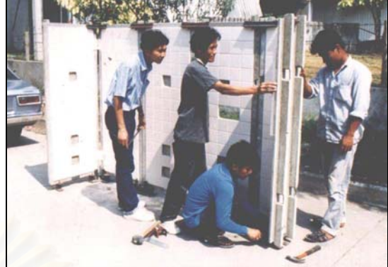
ภาพที่ 4.38 แสดงการประกอบแผ่นผนังต่อเนื่องตัวมุม
