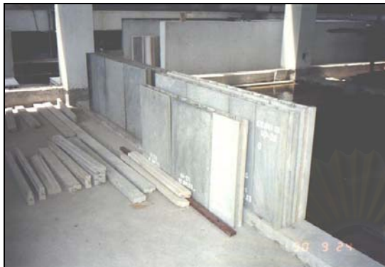
ภาพที่ 4.7 แสดงแผ่นผนังกลวงรูปแบบต่างๆ
