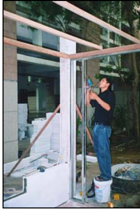
ภาพที่ 4.101 แสดงขั้นตอนการติดตั้งผนังยิปซัมบอร์ด
