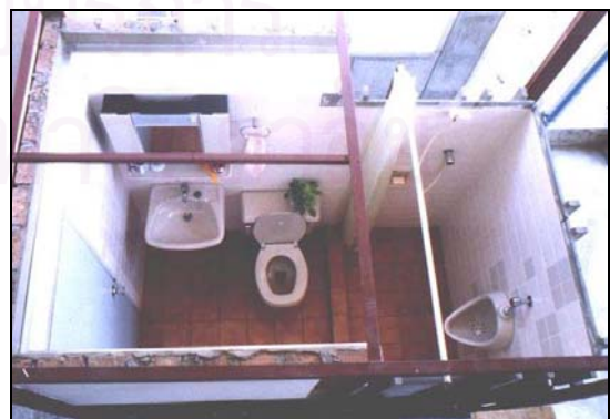
ภาพที่ 4.48 แสดงห้องน้ำสำเร็จรูปที่ติดตั้งสุขภัณฑ์และพร้อมที่จะใช้งานได้
