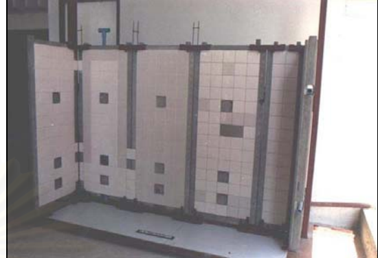
ภาพที่ 4.32 แสดงแผ่นผนังห้องน้ำพร้อมช่องติดตั้งท่อน้ำ
