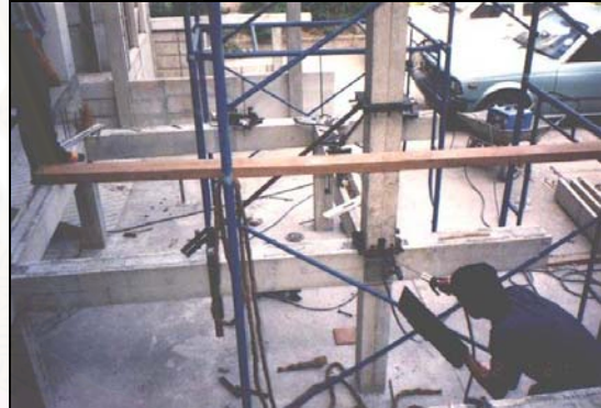
ภาพที่ 4.74 แสดงการเชื่อมเหล็กเสา ภายหลังปรับระดับ - ดิ่ง - ยึดโดยเครื่องช่วยเรียบร้อยแล้ว
