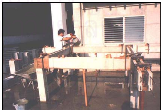
ภาพที่ 4.70 แสดงการเทคอนกรีตบริเวณรอยต่อเสา - คาน
