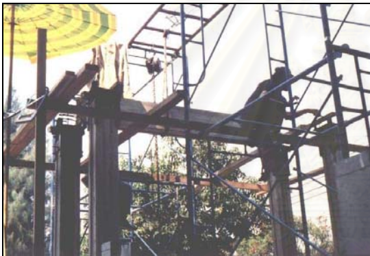
ภาพที่ 4.79 แสดงคานที่นำขึ้นติดตั้งบนหัวเสาแล้ว รอการเทคอนกรีตบริเวณรอยต่อ
