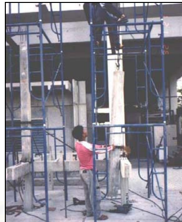
ภาพที่ 4.72 แสดงการยกเสาชั้นสองขึ้นติดตั้ง
