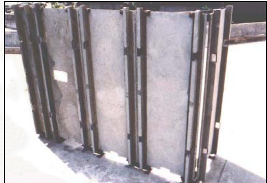
ภาพที่ 4.40 แสดงแผ่นผนังด้านนอกที่ติดตั้งเข้าที่แล้ว ก่อนการเทเอ็น คสล.
