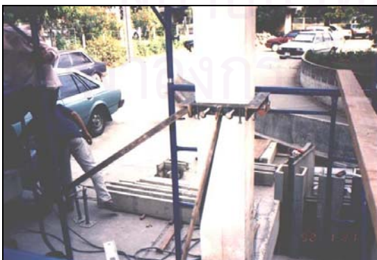
ภาพที่ 4.75 แสดงเครื่องช่วยติดตั้งค้ำยันเสาให้ได้ดิ่ง - ระดับ
