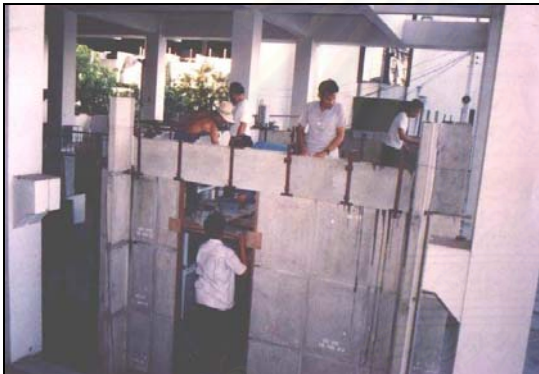
ภาพที่ 4.87 แสดงการเช็คคอนกรีตที่เทไปแล้ว และปรับให้เรียบเสมอระดับหลังคาน
