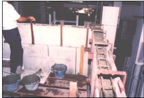
ภาพที่ 4.86 แสดงการเทคอนกรีตตรงกลางระหว่างแบบหล่อคานสำเร็จรูปทั้ง 2 ชั้น
