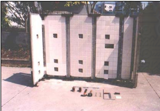
ภาพที่ 4.39 แสดงแผ่นผนังด้านในที่ติดตั้งเข้าที่แล้ว ก่อนการเทเอ็น คสล. และปิดกระเบื้องตามแนวรอยต่อ
