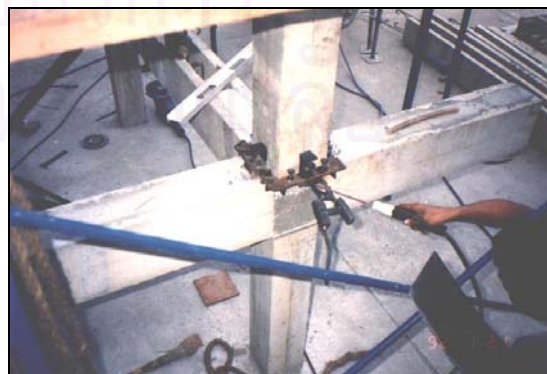
ภาพที่ 4.76 แสดงเครื่องช่วยติดตั้งบริเวณรอยต่อเสา - คาน
