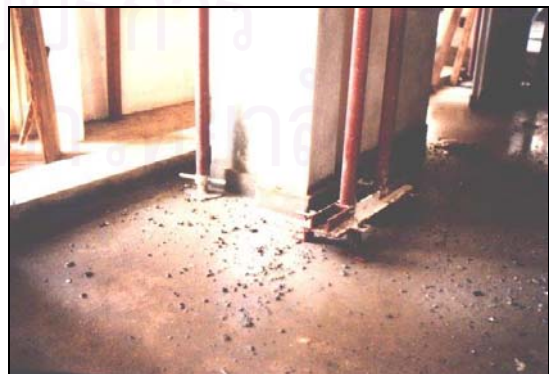
ภาพที่ 4.90 แสดงค้ำยันส่วนล่าง ที่สามารถปรับระดับความสูงได้ตามที่กำหนดไว้ในแบบ
