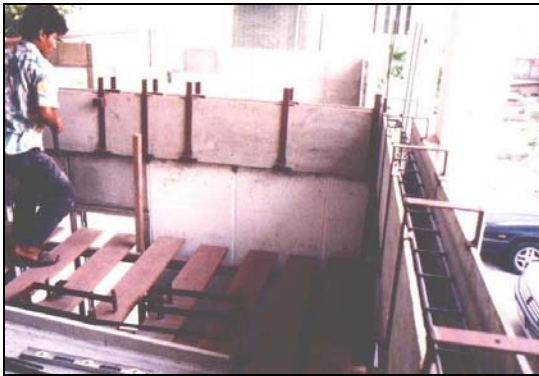
ภาพที่ 4.85 แสดงการใช้เครื่องช่วยและระบบค้ำยัน ในการประกอบแผ่นแบบหล่อคาน
