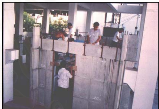
ภาพที่ 4.94 แสดงคานที่สร้างจากแบบหล่อสำเร็จรูป
