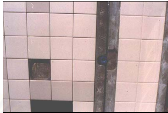
ภาพที่ 4.44 แสดงช่องเดินท่อที่เตรียมไว้ก่อนถูกระเบียง
