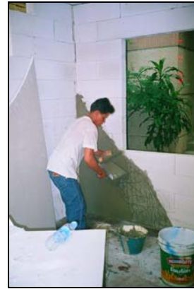
ภาพที่ 4.100 แสดงขั้นตอนการก่อผนัง การฉาบปูนเรียบ การติดแผ่นยิปซัม และการทาสี
