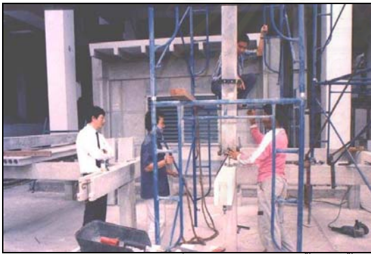
ภาพที่ 4.73 แสดงการใช้เครื่องช่วยในการยกเสาชั้นสองขึ้นติดตั้งเหนือคานที่ติดตั้งเสร็จแล้ว
