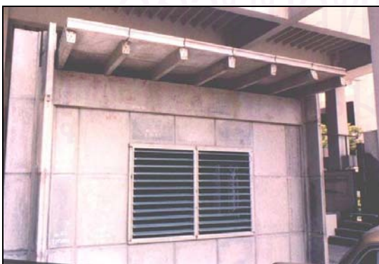
ภาพที่ 4.95 แสดงคานจากแบบหล่อสำเร็จ ร่วมกับโครงสร้างผนังแผ่นกลวงและพื้นแผ่นกลวงสำเร็จรูป
