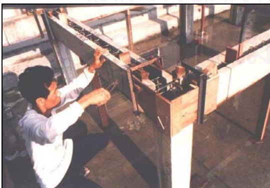
ภาพที่ 4.69 แสดงการประกอบแบบหล่อในจุดรอยต่อเสาคาน
