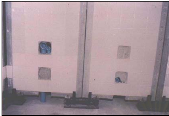
ภาพที่ 4.43 แสดงช่องเดินท่อผ่านทะลุผนังห้อง
