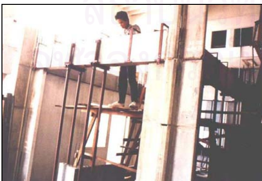
ภาพที่ 4.89 แสดงระบบเครื่องช่วยและค้ำยัน ของช่วงคานสำเร็จที่ยาว 3.00 ม.
