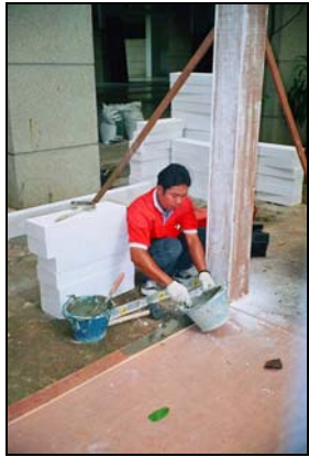
ภาพที่ 4.99 แสดงขั้นตอนการก่อผนังอิฐมวลเบา
