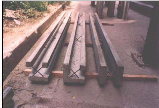
ภาพที่ 4.66 แสดงเสา กึ่งสำเร็จรูปแบบต่างๆตามลักษณะของผนังที่มาเชื่อมต่อทั้งแบบ Straight, L และ T Joint
