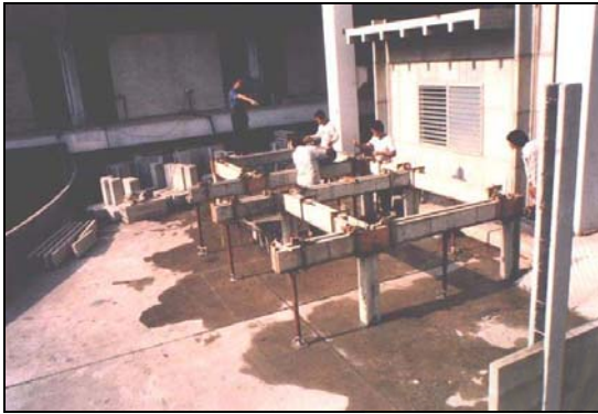
ภาพที่ 4.71 แสดงการเทคอนกรีตในคานที่เป็นแบบหล่อในตัว
