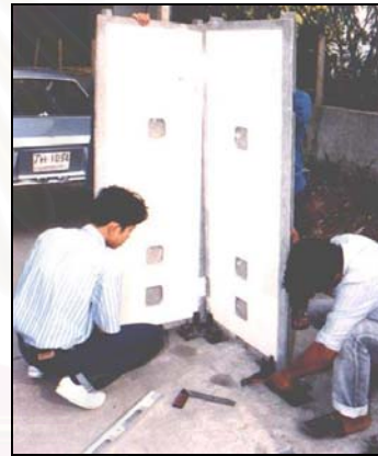
ภาพที่ 4.34 แสดงการติดตั้งแผ่นเข้ามุม โดยใช้เครื่องช่วยติดตั้งที่สามารถปรับระดับและระยะห่างระหว่างแผ่นได้
