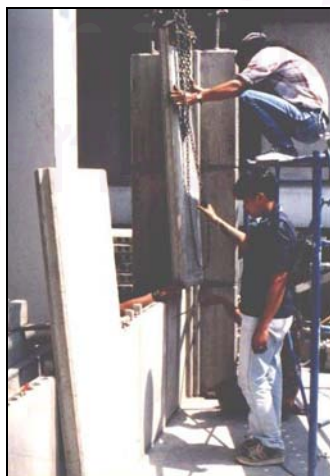
ภาพที่ 4.23 แสดงการยกแผ่นผนังขึ้นติดตั้ง
