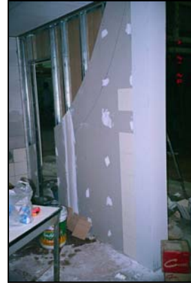
ภาพที่ 4.101 แสดงขั้นตอนการติดตั้งผนังยิปซัมบอร์ด
