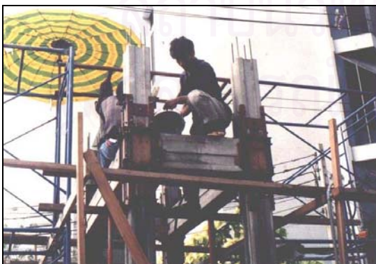
ภาพที่ 4.81 แสดงการเทคอนกรีตในจุดเชื่อมต่อระหว่างคานและเสาชั้นสอง
