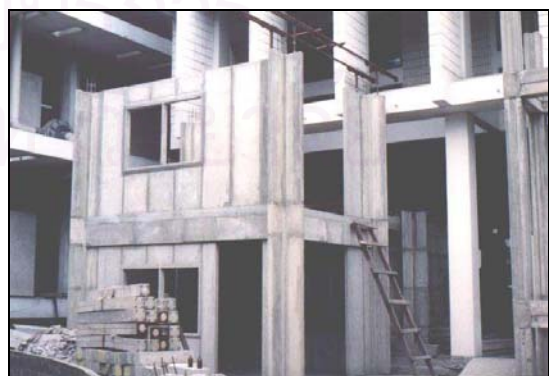
ภาพที่ 4.96 แสดงแบบหล่อคาน (ระบบเฟอร์โรซีเมนต์) สำหรับอาคาร 2 ชั้น ร่วมกับผนังแผ่นกลวงสำเร็จรูป
