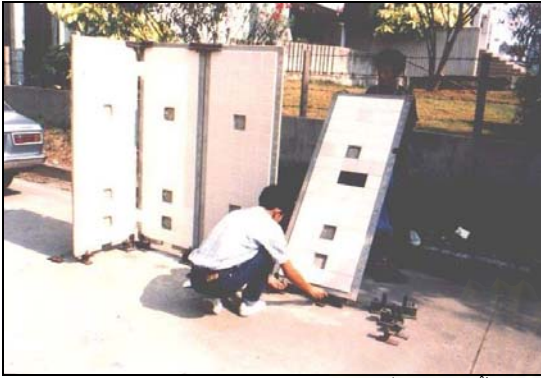
ภาพที่ 4.37 แสดงการยกแผ่นผนังต่อเนื่องเข้าติดตั้ง
