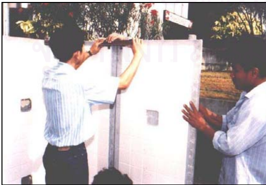
ภาพที่ 4.35 แสดงการติดตั้งแผ่นต่อเนื่องโดยใช้เครื่องช่วย
