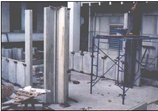
ภาพที่ 4.19 แสดงแผ่นผนังที่ประกอบเป็นแบบหล่อเสา คสล.
