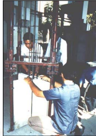
ภาพที่ 4.14 แสดงการติดตั้งแผ่นเสาโดยใช้เครื่องช่วย
