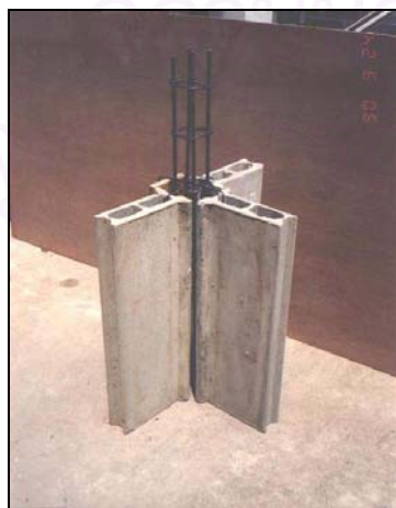
ภาพที่ 4.11 แสดงการติดตั้งแผ่นเสา 3 แผ่น
