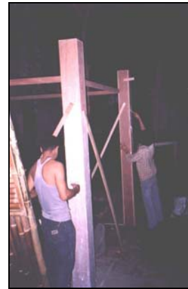
ภาพที่ 4.98 แสดงขั้นตอนการติดตั้งโครงสร้างเสา
