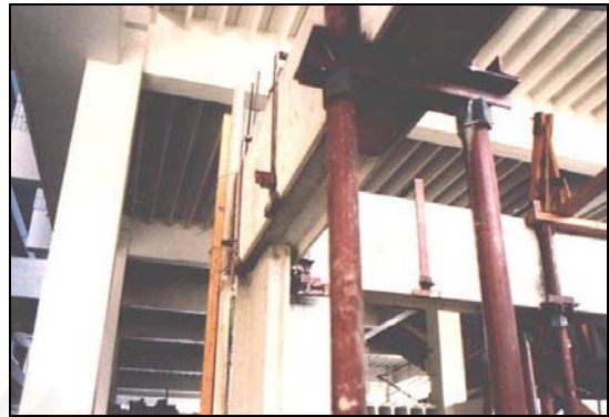
ภาพที่ 4.92 แสดงรายละเอียดเครื่องช่วยและค้ำยันส่วนบนซึ่งต่อฐานลงมาที่ระดับพื้น และปรับระดับได้
