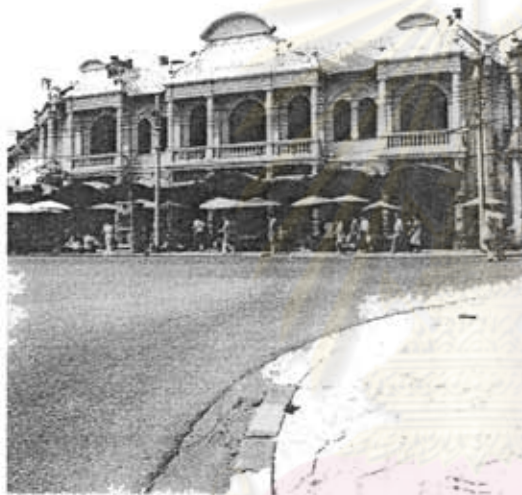
ภาพที่ 4.14 อาคารพาณิชย์แถบถนนมหาสาร
