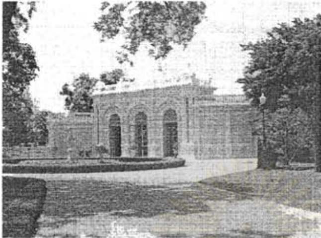
ภาพที่ 4.13 พระราชวังบางปะอิน จ.พระนครศรีอยุธยา ที่มา : พัทธณี จันทรสชา, การอนุรักษ์พระราชวัง มรดกสำคัญของชาติ, หน้า 19.
