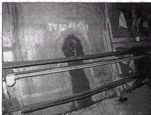
รูปที่ 4.14 การรั่วไหลของน้ำบริเวณรูฉีदनํ้าปูน
