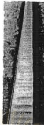
รูปที่ 4.24 การเป็นลอนลูกฟูกของราง (กิจการร่วมค้า ซีเคเอสแอล, 2545)
