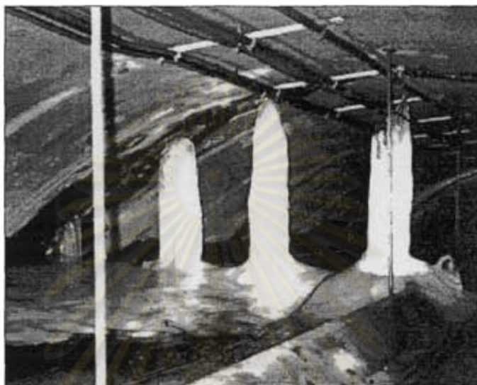
รูปที่ 2.1 การก่อตัวเป็นน้ำแข็งย่อยเหนือเพดานอุโมงค์ (FHWA และ FTA, 2003)
