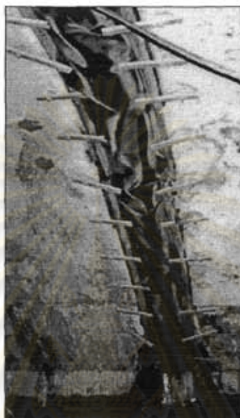
รูปที่ 2.2 การใช้รางน้ำไหลเพื่อการซ่อมแซมการรั่วไหลของน้ำ (FHWA และ FTA, 2003)
