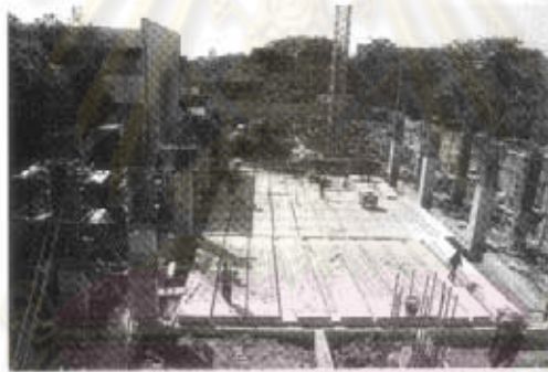
ขณะนี้อยู่ในระหว่างดำเนินการก่อสร้างดังกล่าว
