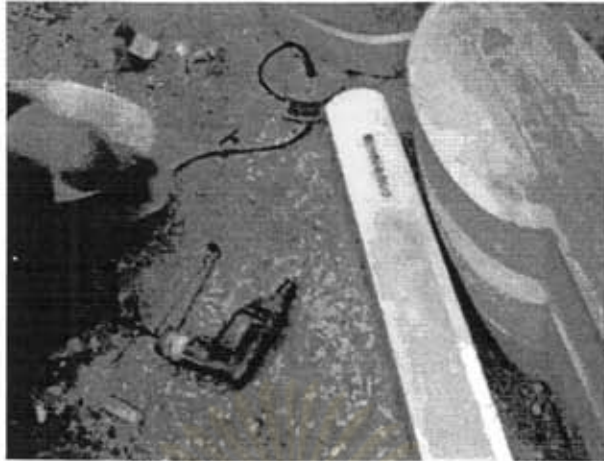
ภาพการเจาะช่องรั้งใหม่ด้วยสว่านไฟฟ้า
