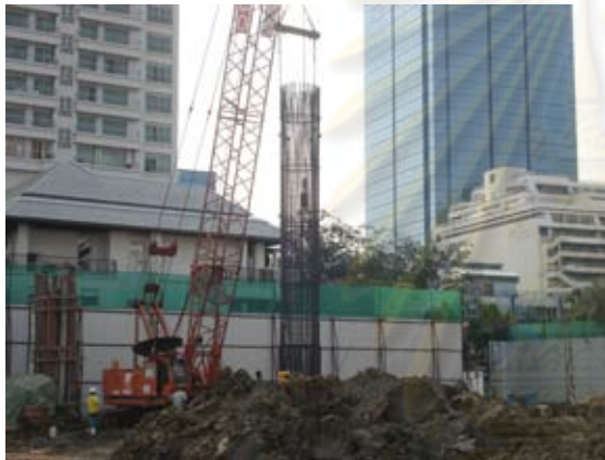
c) Install rebar cage
