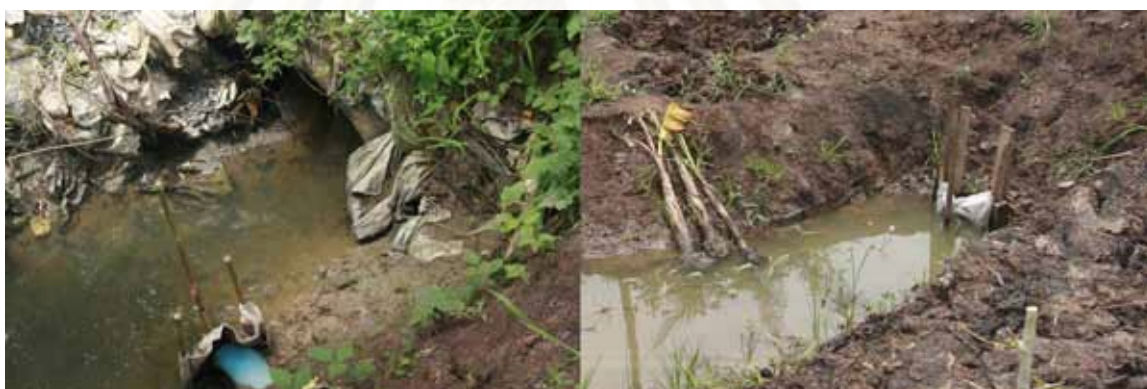
ภาพที่ 3-7 แสดงจอและท่อลอดที่ใช้ในพื้นที่วิจัย (การสำรวจพื้นที่ 12 พ.ค. 2552)
