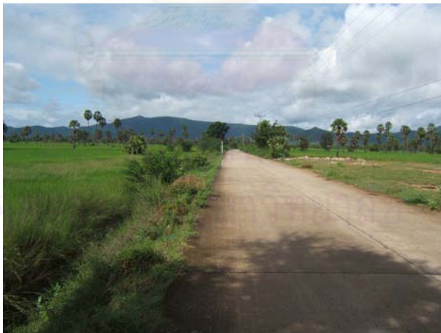
ภาพที่ 15 ถนนเข้าสู่หมู่ 6 บ้านดงห้วยหลวงในช่วงแรก เป็นถนนคอนกรีตเสริมเหล็ก
