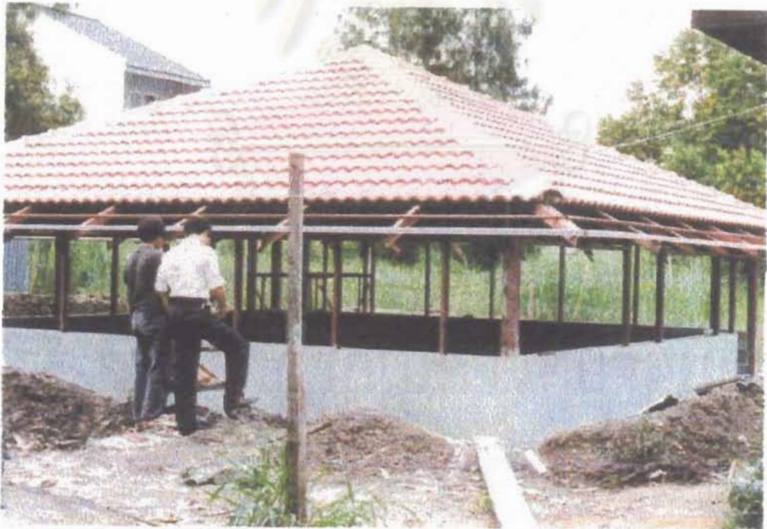
รูปที่ 2-1 ค. แสดงอาคารทดลองที่เตรียมการถมดินและติดตั้งเครื่องมือ
