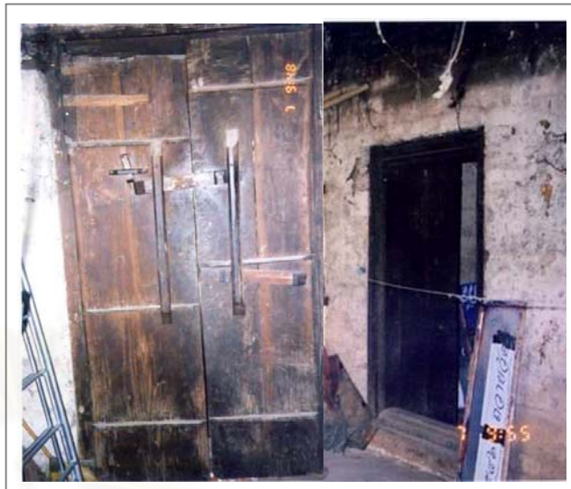
ภาพที่ 47. ประตูไม้บานเปิดภายในอาคาร
