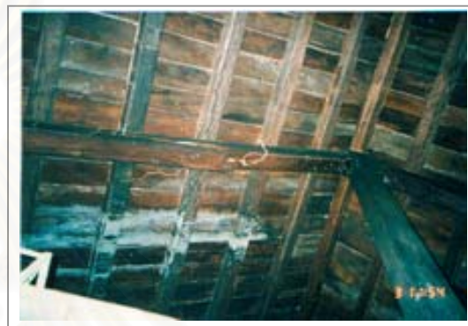
ที่มา : จากการสำรวจ ภาพที่ 79. แสดงแผ่นไม้รับก้อนอิฐดินดิบในส่วน หลังคาชั้นล่าง
