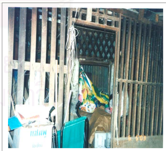
ภาพที่ 69. ผนังระแนงไม้ในส่วนครัว
