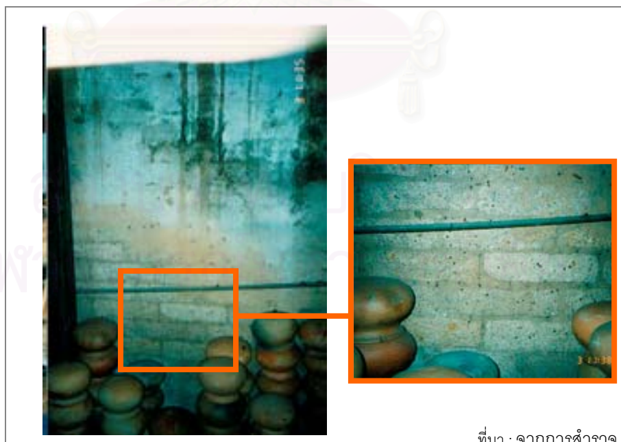
ภาพที่ 77. ผนังอิฐดินดิบภายในตึกดิน
