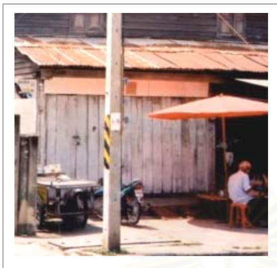
ภาพที่ 24. ประตูด้านหน้าอาคาร
