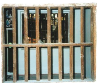
ภาพที่ 71. หน้าต่างลูกกรงไม้ติดตายภายในตึกดิน
