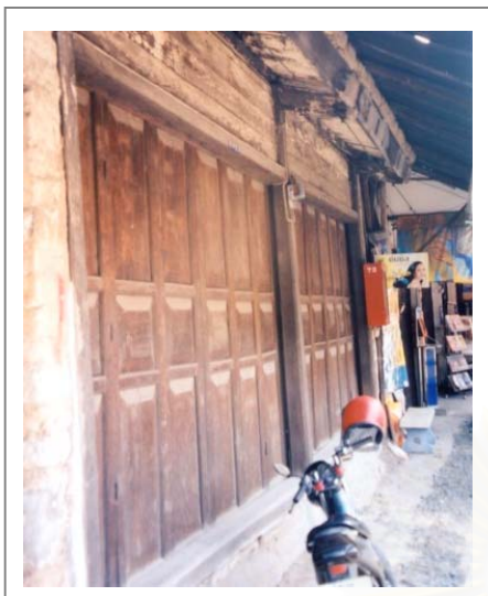
ภาพที่ 46. ประตูไม้บานเพี้ยมด้านหน้าอาคาร
