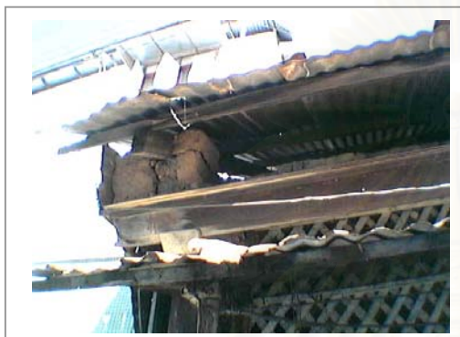
ที่มา : จากการสำรวจ ภาพที่ 78. แสดงหลังคาสองชั้นบริเวณชายคา ด้านหน้า
