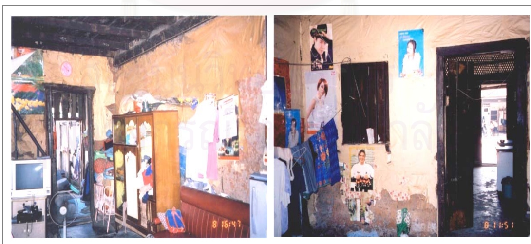
ภาพที่ 134. การนำภาพมาติดผนังโดยใช้เทปกาวซึ่งทำให้ดินที่ใช้ฉาบผนังหลุดร่อน
