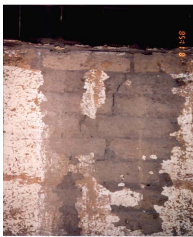
ความเสียหายที่เกิดจาก ความชื้นที่ลงมาจากหลังคา
