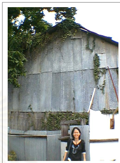
ภาพที่ 12. สังกะสีและไม้แผ่นตีปิดทั้งด้านข้างและด้านหลัง
