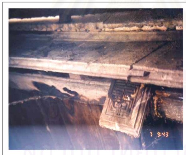
ภาพที่ 54. แผ่นไม้แกะลายบริเวณเชิง ชายและแผ่นปิดจันทัน
