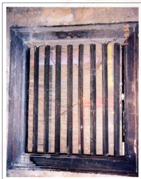
ภาพที่ 48. หน้าต่างลูกกรงไม้ติดตาย
