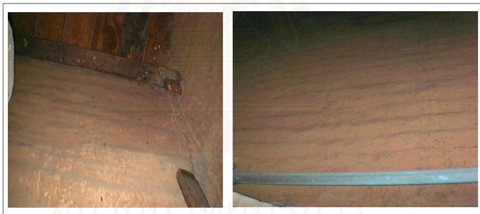
ภาพที่ 61. ผนังก่ออิฐดินดิบภายในตึกดิน
