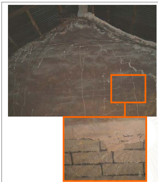
ภาพที่ 11. เส้นฟางสับในเนื้อวัสดุอิฐดินดิบ
