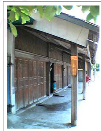
ที่มา : จากการสำรวจ ภาพที่ 35. เสารับชายคา
