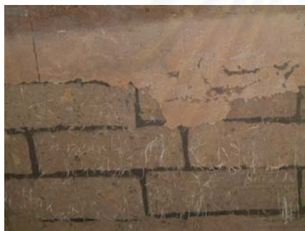
ความเสียหายที่เกิดจาก ความชื้นที่ลงมาจากหลังคา
