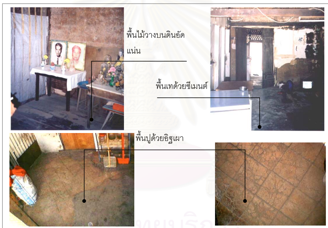
ภาพที่ 115. วัสดุที่พื้นในส่วนชั้นล่างของตึกดิน
