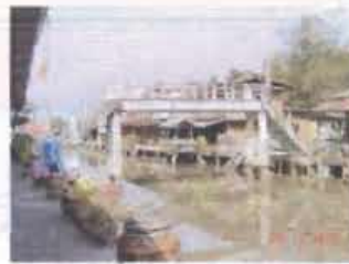
สะพานข้ามคลอง
