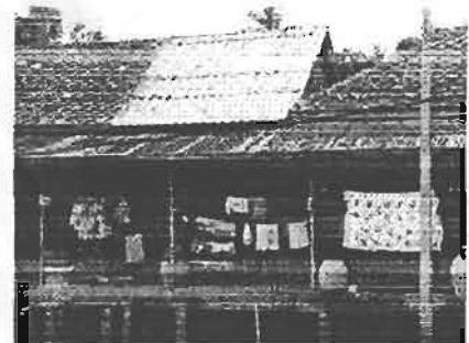
การเปลี่ยนแปลงวัสดุโดยไม่สอดคล้องกับของเดิม
