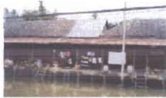
การต่อเติม เปลี่ยนแปลงรูปทรงไปจากเดิม
