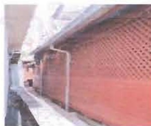
ลักษณะหน้าต่างแบบบานเปิดคู่ไม้และแบบเจาะช่องลม
