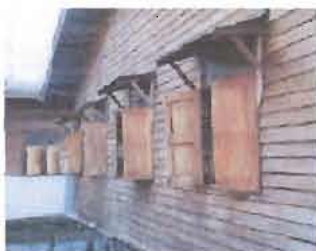
ลักษณะหน้าต่างแบบบานเปิดคู่ไม้และแบบเจาะช่องลม
