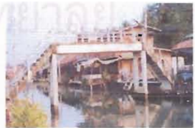
สะพาน ค.ส.ล
