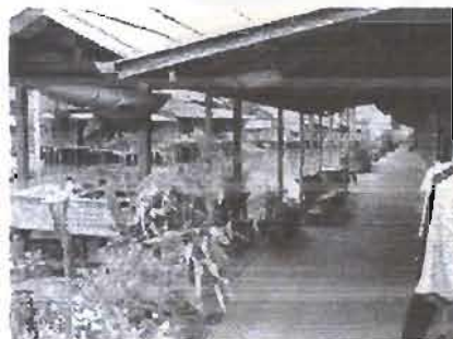
ทางเดินคอนกรีตเสริมเหล็กเชื่อมต่อบ้าน
