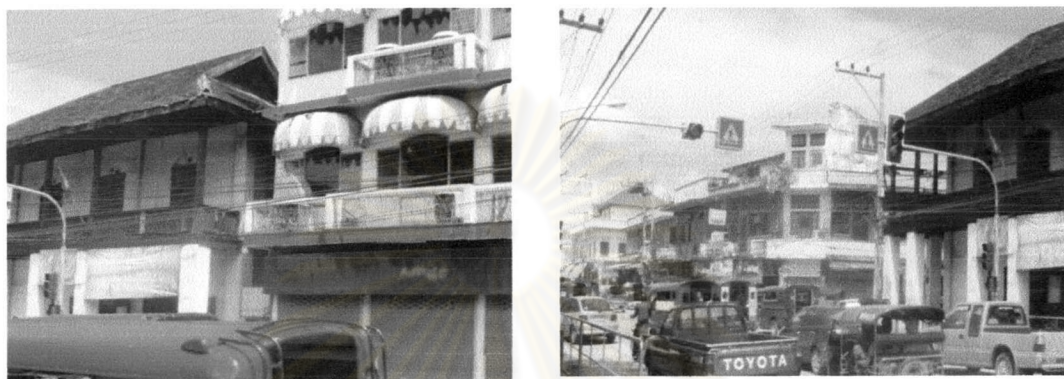
รูปภาพ 4.17 แสดง โครงสร้างอาคาร ที่ไม่ต่อเนื่องกัน บริเวณถนนท่าแพ
