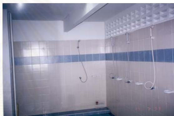
ห้องน้ำและห้องอาบน้ำอยู่ภายในสถานที่ซ้อม
