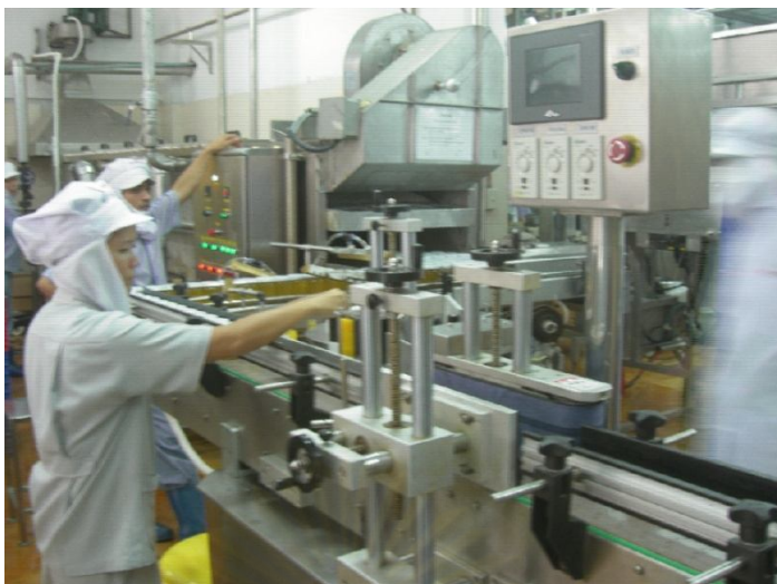
รูปที่ 4.25 การติดตั้งเครื่องติดฉลาก
