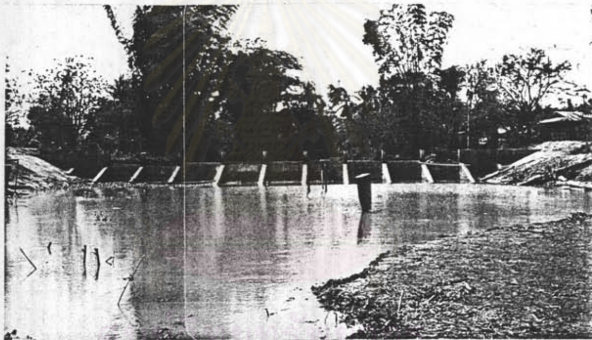
รูปที่ 2-29 สภาพฝายทดน้ำบ้านด่านแม่คามัน ก่อสร้างโดย สำนักงาน รพช.
