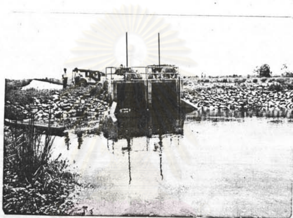
รูปที่ 3-2 ประตูระบายน้ำ 2 = 2.40 x 2.40 เมตร
