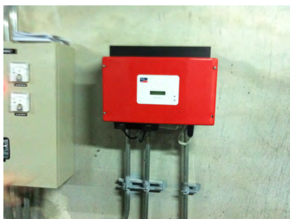
รูปที่ 9.3 อินเวอร์เตอร์จากบริษัท SMA Solar จำกัด (มหาชน) รุ่น 2100TL
