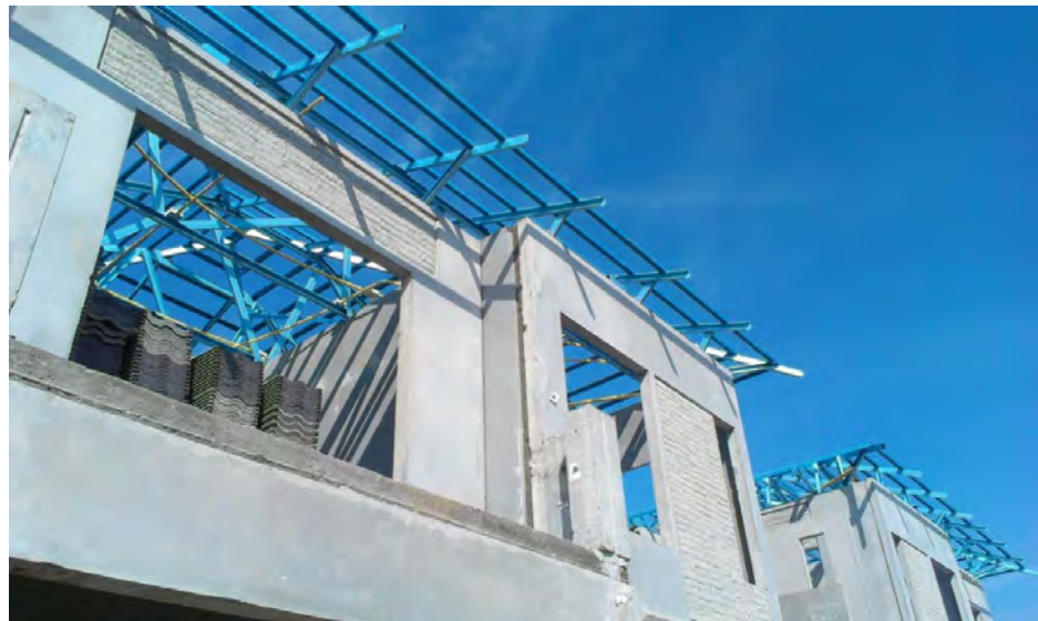
ภาพที่ 3.40 โครงหลังคาสำเร็จรูป ที่มา: จากการสำรวจ
