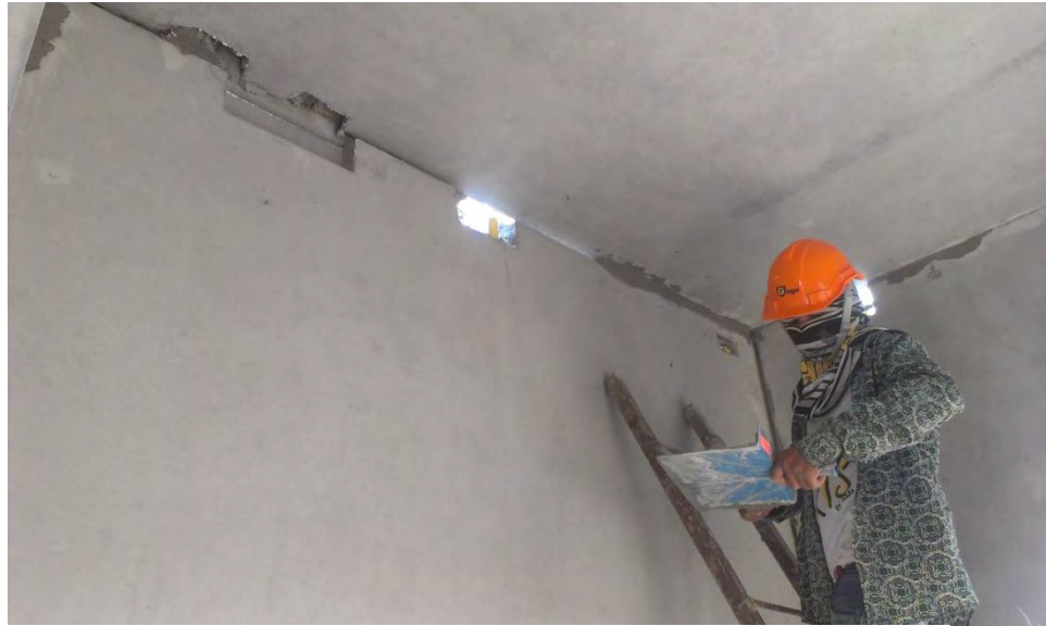
ภาพที่ 3.38 เก็บรายละเอียดรอยต่อระหว่างผนังชั้นที่ 1 และพื้นชั้นที่ 2 ที่มา: จากการสำรวจ
