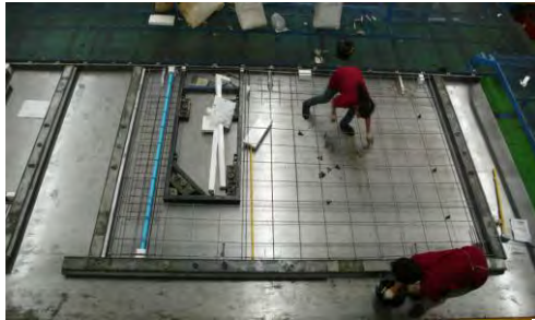
ภาพที่ 3.11 คนงานกำลังวางอุปกรณ์ ที่มา: จากการสำรวจ
