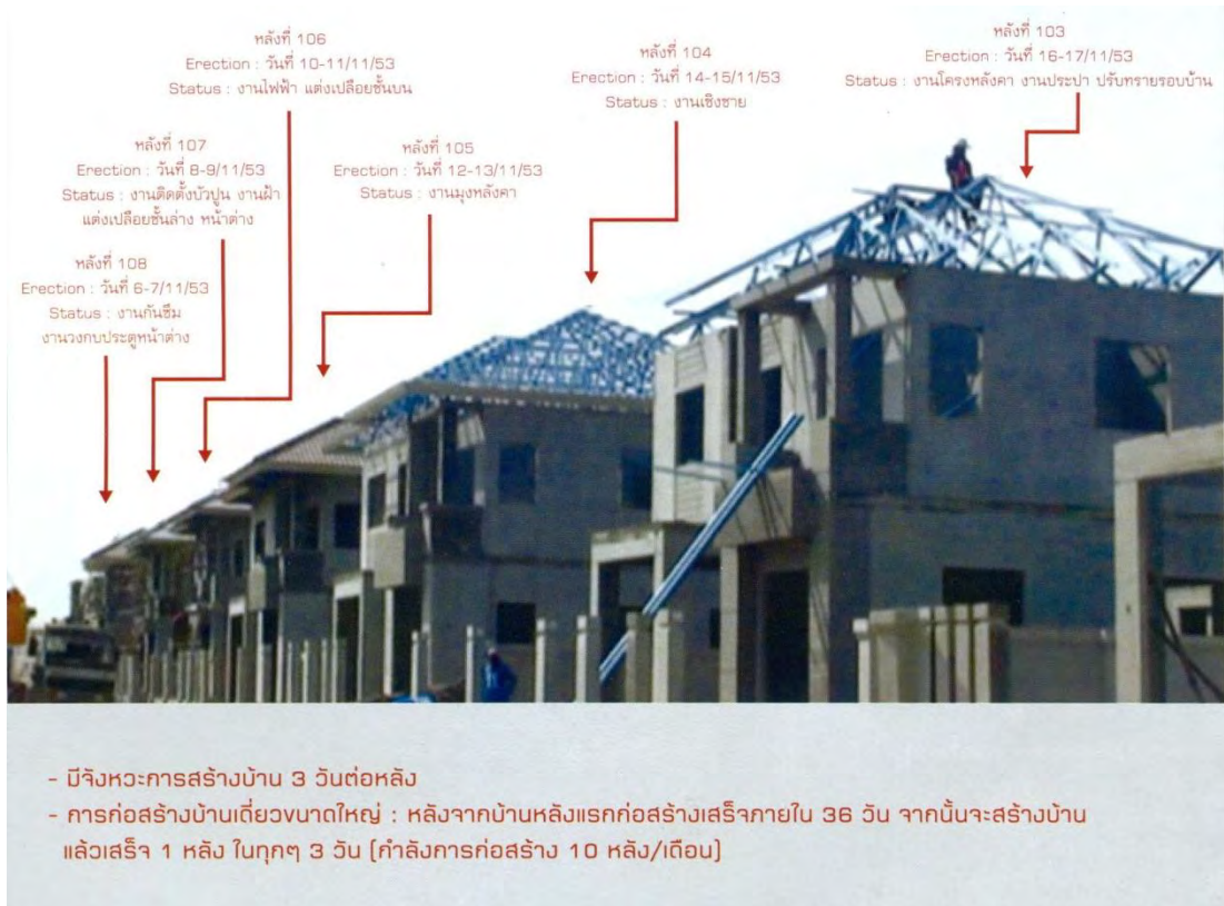
ภาพที่ 3.30 การทำงานอย่างต่อเนื่องในแต่ละขั้นตอน
