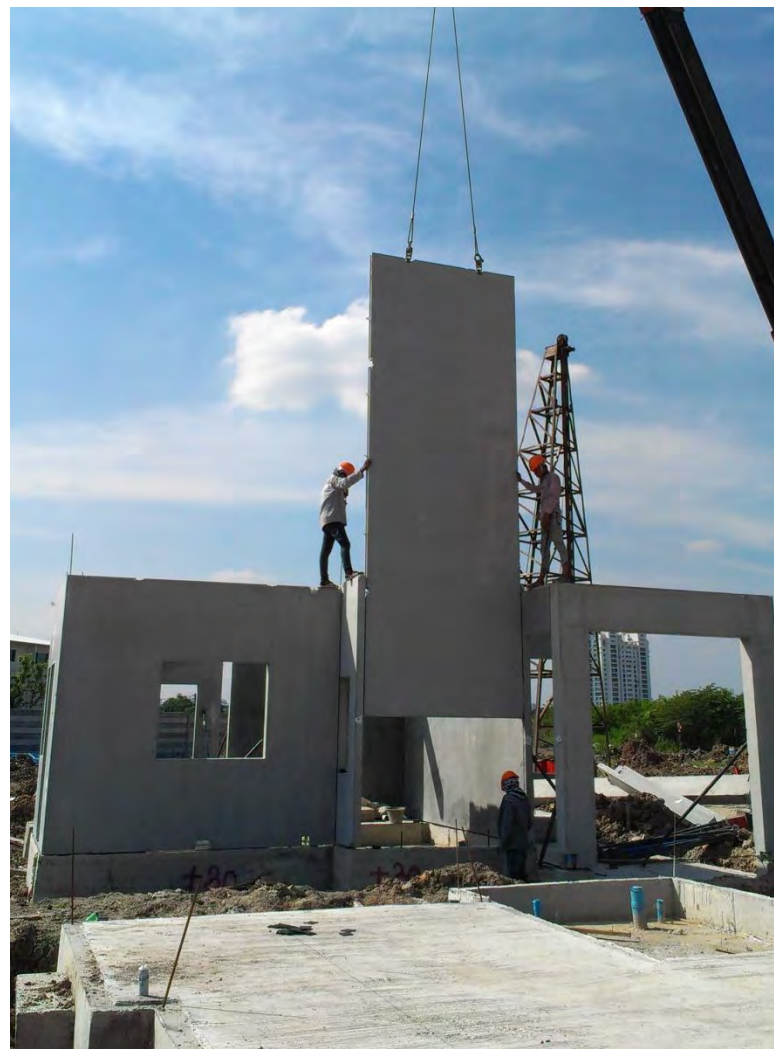
ภาพที่ 3.35 การติดตั้งผนังชั้นที่ 1
