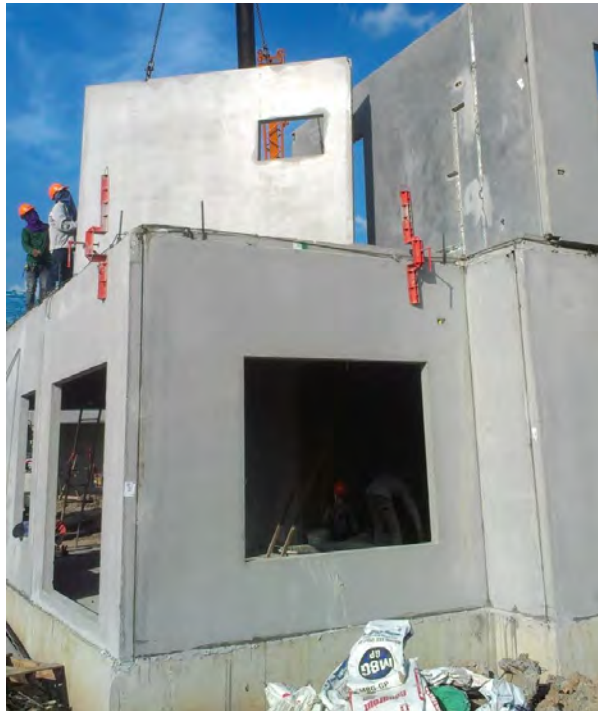
ภาพที่ 3.36 การติดตั้งผนังชั้นที่ 2 ที่มา: จากการสำรวจ
