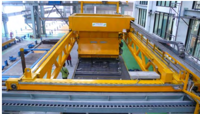
ภาพที่ 3.16 เครื่องเทคอนกรีตขณะเทคอนกรีต
