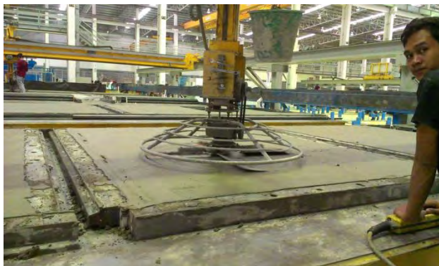
ภาพที่ 3.18 เครื่องขัดผิวคอนกรีต
