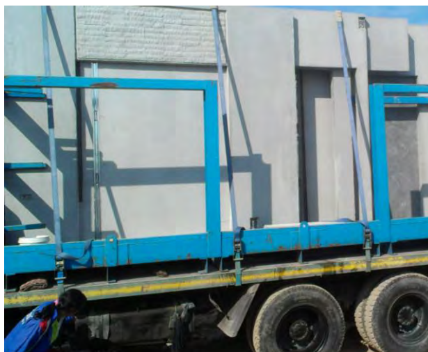
ภาพที่ 3.27 สายรัดระหว่างชิ้นงานและรถบรรทุก ที่มา: จากการสำรวจ
