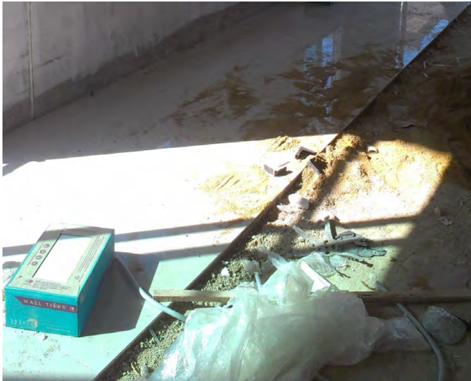
ภาพที่ 3.46 งานปูกระเบื้องพื้นบริเวณชั้น 1 ที่มา: จากการสำรวจ
