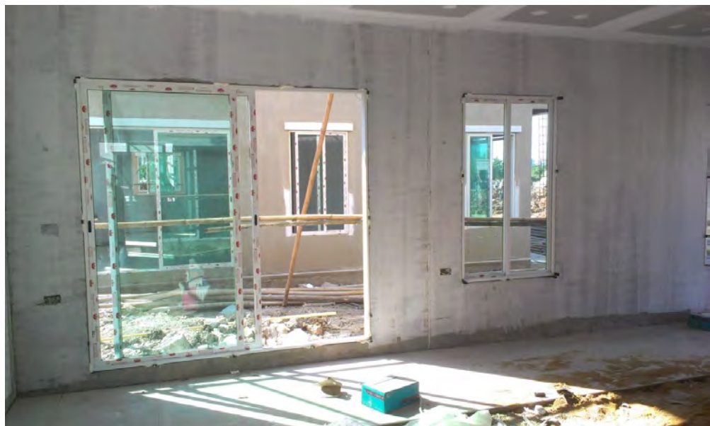
ภาพที่ 3.43 การติดตั้งวงกบประตูและหน้าต่าง
