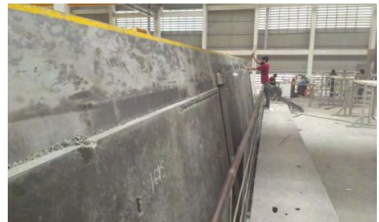
ภาพที่ 3.23 คนงานกำลังถอดชิ้นงานออกจากโต๊ะหล่อ
