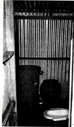
รูปภาพที่ 7.32.2 ห้องน้ำสร้างใหม่
