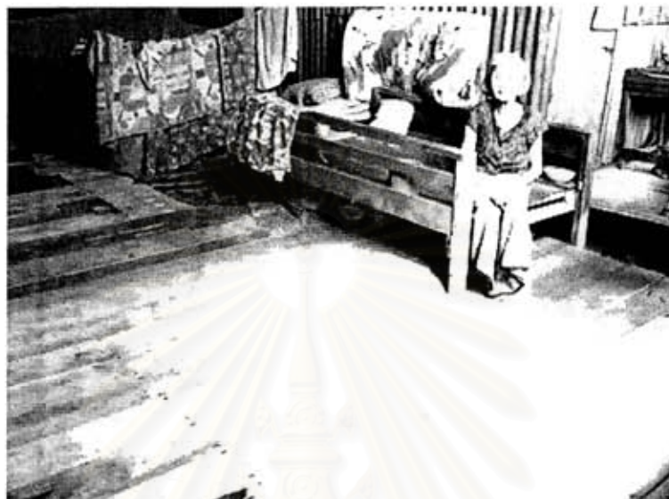
รูปภาพที่ 6.16 ใช้ฝาไม้จริงตีเป็นพื้น
