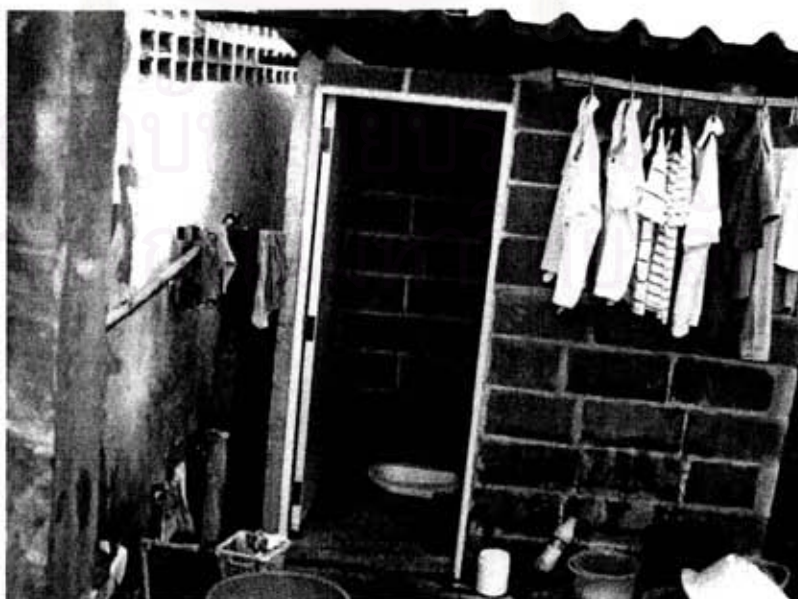
รูปภาพที่ 7.43.1 ห้องน้ำสร้างใหม่
