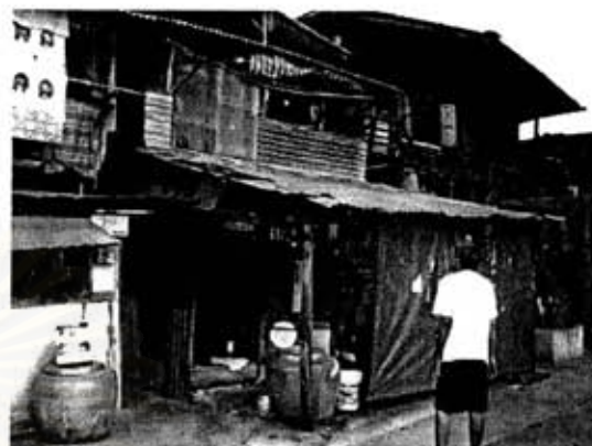
รูปภาพที่ 7.4.1 ลุงเคนมองบ้านที่ซ่อมแซมแล้ว
