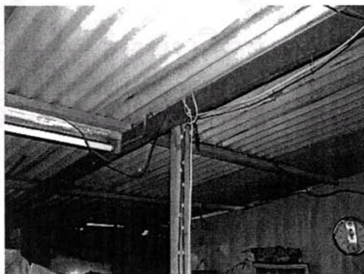
รูปภาพที่ 7.52.2 หลังคาที่ซ่อมแล้ว
