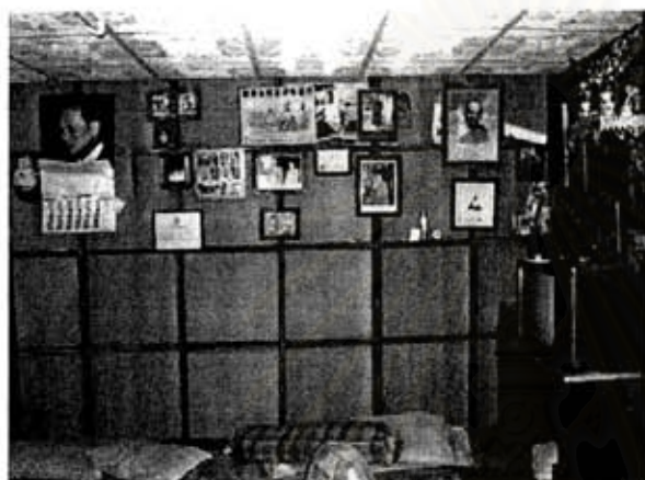
รูปภาพที่ 7.1.3 วัสดุผนังที่ใช้ซ่อมแซม
