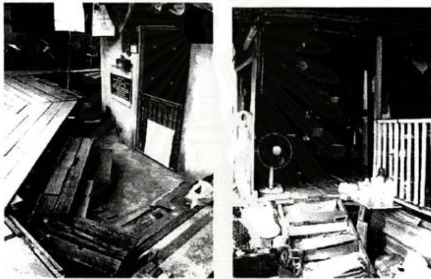
รูปภาพที่ 6.3 พื้นต่างระดับที่ไม่เหมาะสม
