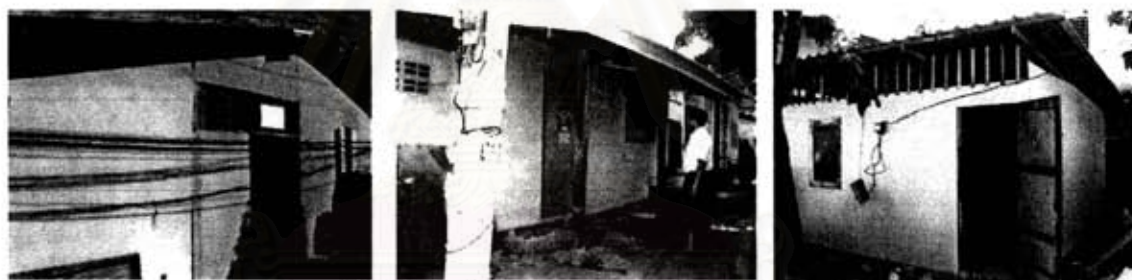
รูปภาพที่ 5.3 สภาพบ้านที่สร้างใหม่ ทั้ง 3 หลัง
