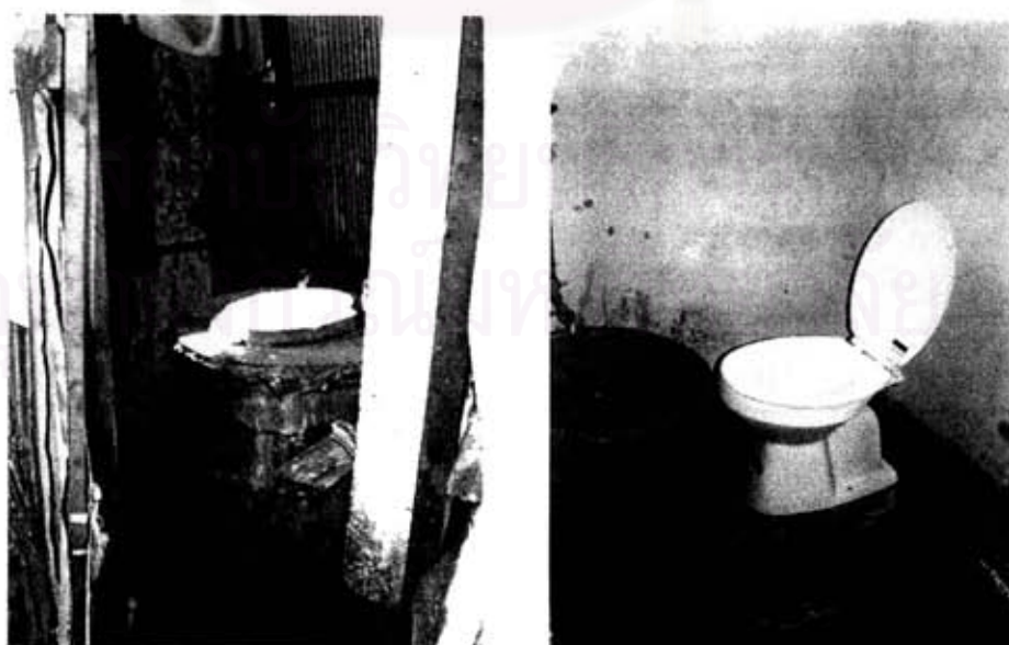
รูปภาพที่ 6.11 เปลี่ยนชนิดโถส้วมให้เหมาะสม
