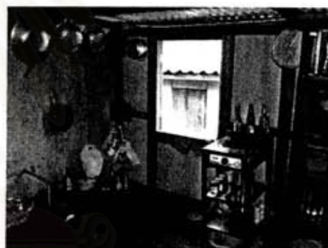
รูปภาพที่ 7.22.2 ผนังที่ซ่อมแซมแล้ว
