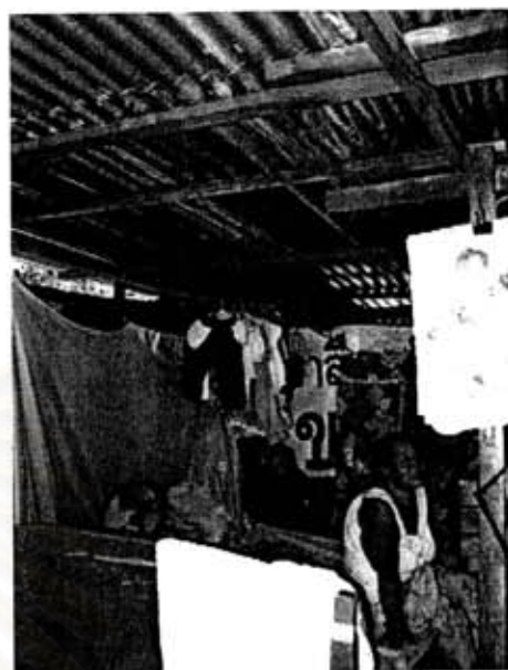
รูปภาพที่ 7.41.1 หลังคาที่ซ่อมแล้ว
