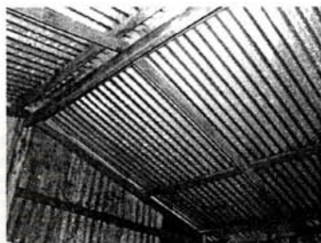
รูปภาพที่ 6.12 วัสดุบุหลังคาที่ใช้ซ่อมแซมในปัจจุบัน
