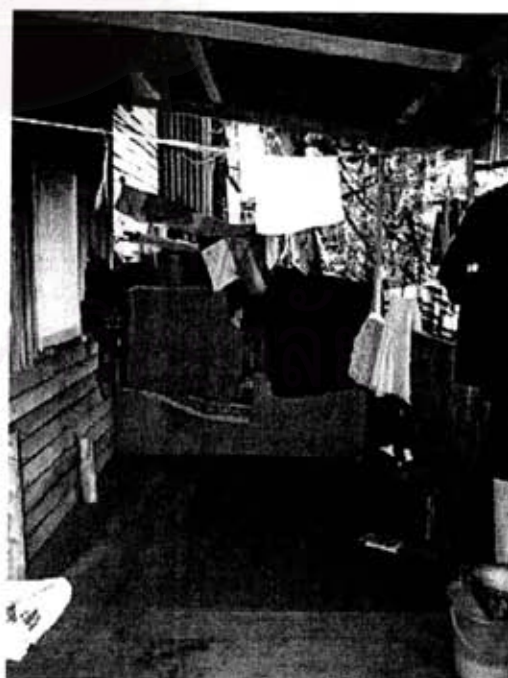
รูปภาพที่ 7.15.3 ส่วนที่ได้รับการซ่อมแซม
