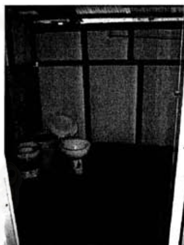
รูปภาพที่ 7.45.2 ห้องน้ำใหม่
