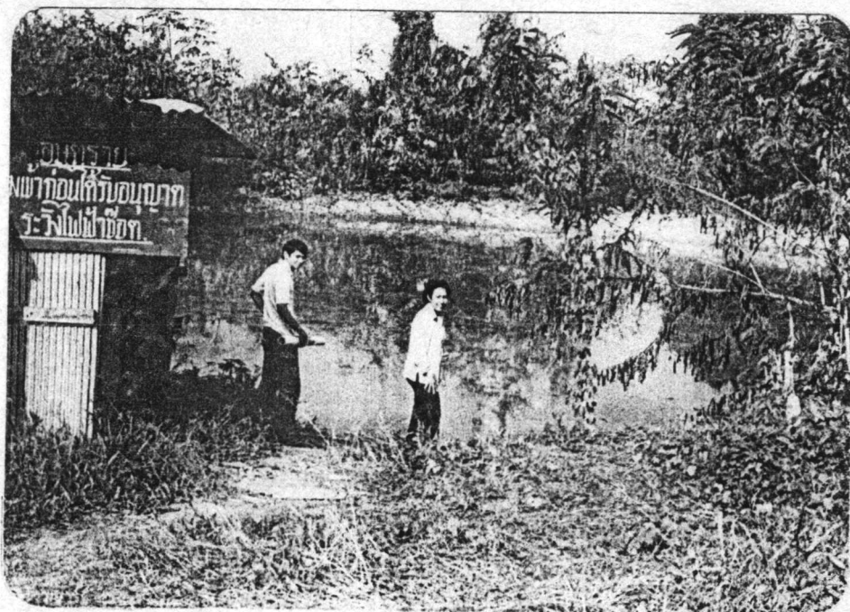
รูปที่ 4 - 1 สภาพของสระน้ำดิบที่บ้านท่าทุ่งนา ซึ่งใช้สูบขึ้นมาทำน้ำประปา เพื่อแจกจ่ายให้กับราษฎรในหมู่บ้านอพยพท่าสะนุ
