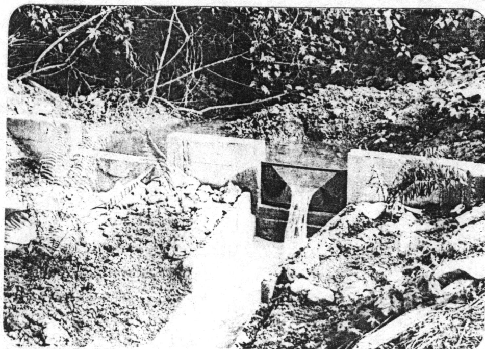
รูปที่ 4 - 2 Weir ที่ใช้วัดปริมาณน้ำที่ไหลเข้าสู่สระน้ำดิบที่บ้านท่าทุ่งนา
