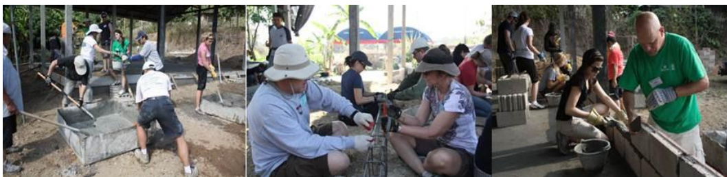
ภาพที่ 5.4 งานก่อสร้างบ้านของมูลนิธิที่อยู่อาศัยประเทศไทย ที่อาสาสมัครร่วมทำงานได้ ที่มา: มูลนิธิที่อยู่อาศัยประเทศไทย
