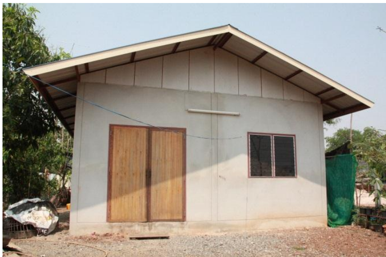
ภาพที่ 5.2 บ้านขนาด 6X6 เมตร ที่ดำเนินการในอุดรธานีก่อนปี พ.ศ.2556
