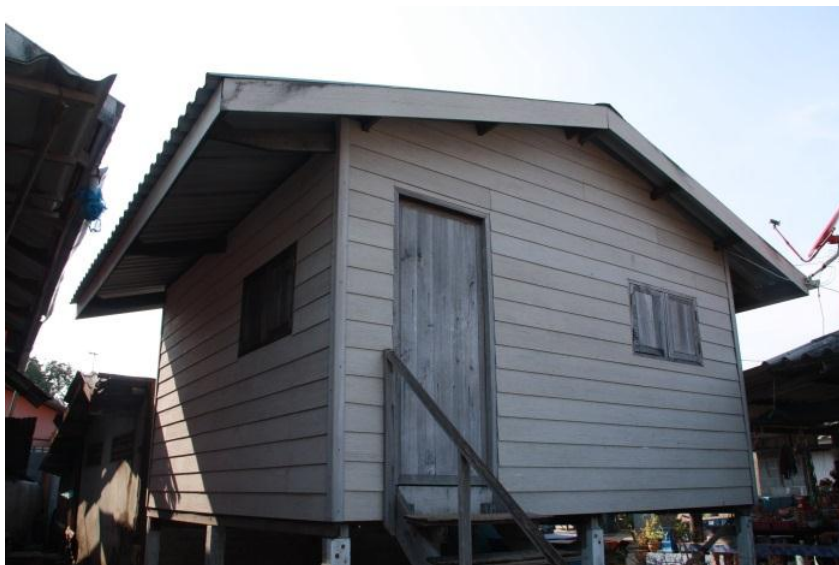
ภาพที่ 5.9 บ้านยกพื้นไม้เฌอร่า ขนาด 6x6 เมตร (สภาพบ้านแบบเดิม)
