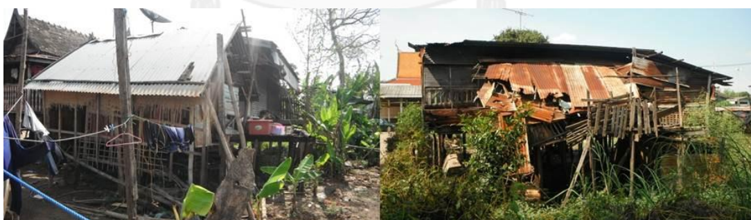
ภาพที่ 5.20 สภาพบ้านเรือนที่ได้รับความเสียหายจากน้ำท่วม ที่มา: มูลนิธิที่อยู่อาศัยประเทศไทย
