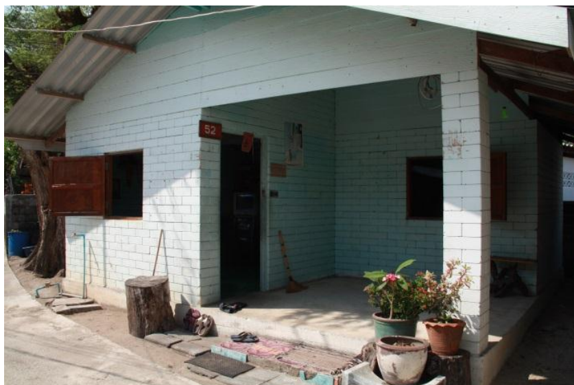
ภาพที่ 5.7 บ้านอิฐดินประสาน ขนาด 6X6 เมตร
