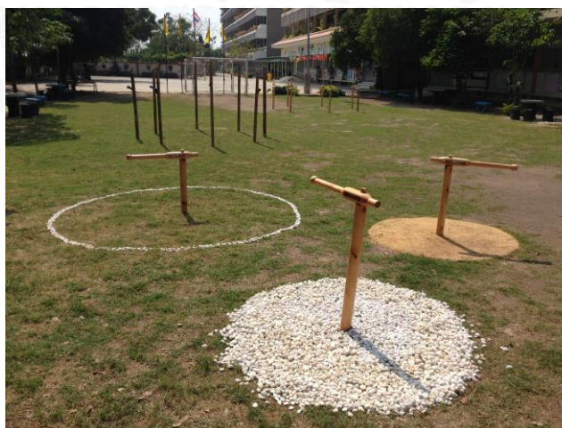
ภาพที่ 4.26 กระเตงเวียนติดตั้งบนพื้นผิว 3 แบบคือ พื้นหญ้า พื้นทราย และพื้นหิน
