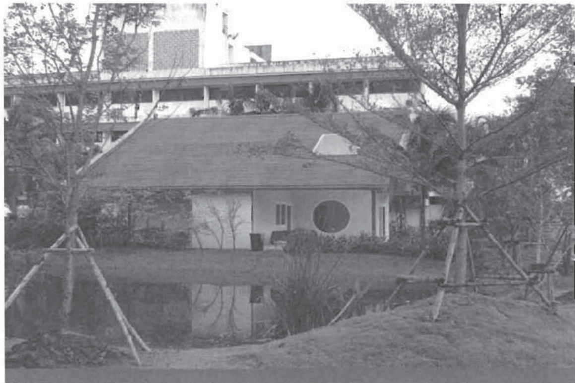
ภาพที่ 32 การติดตั้งผิวหลังคาด้วยแผ่นซีเมนต์ในรูปแบบดินอ่อนซ้อนเกล็ด การเก็บรายละเอียดขอบหลังคาพร้อมช่องแสงกระจกติดตายบนระเบียงชั้นสอง
