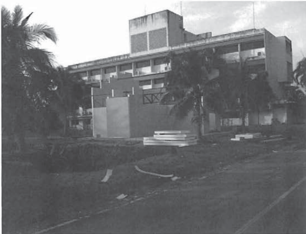
ภาพที่ 30 การก่อสร้างผนังกันตกพร้อมการเสริมการรับแรง เพื่อรับน้ำหนักพื้นระเบียงชั้นสอง Figure 30 Reinforced steel truss to carry balcony loads.
