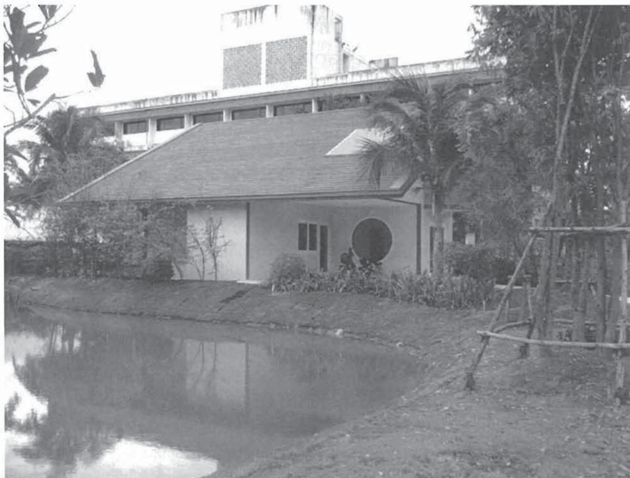
ภาพที่ 33 บ้านพอเพียงเมื่อก่อสร้างแล้วเสร็จมีระบบนิเวศที่สมบูรณ์ พร้อมแหล่งน้ำ
