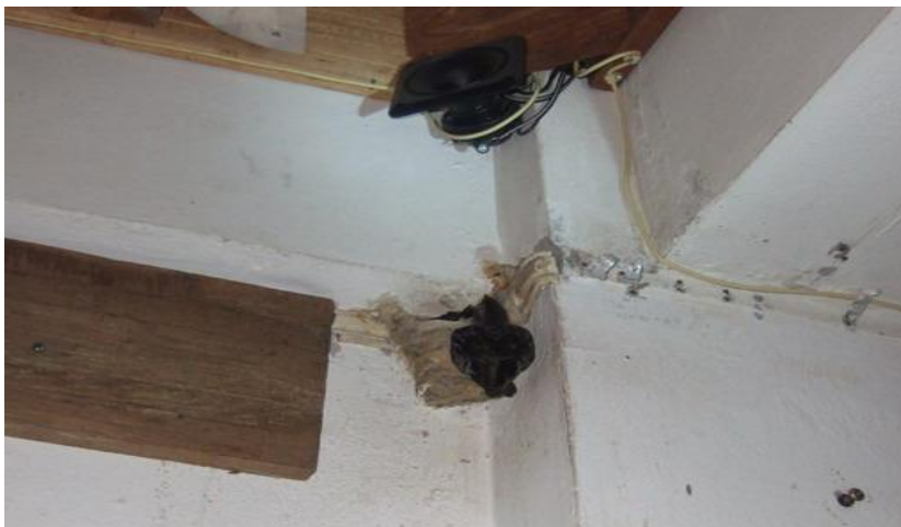
ภาพที่ 11 ลำโพงขยายเสียงเพื่อเรียกให้นกเข้ามาอาศัยทำรัง
