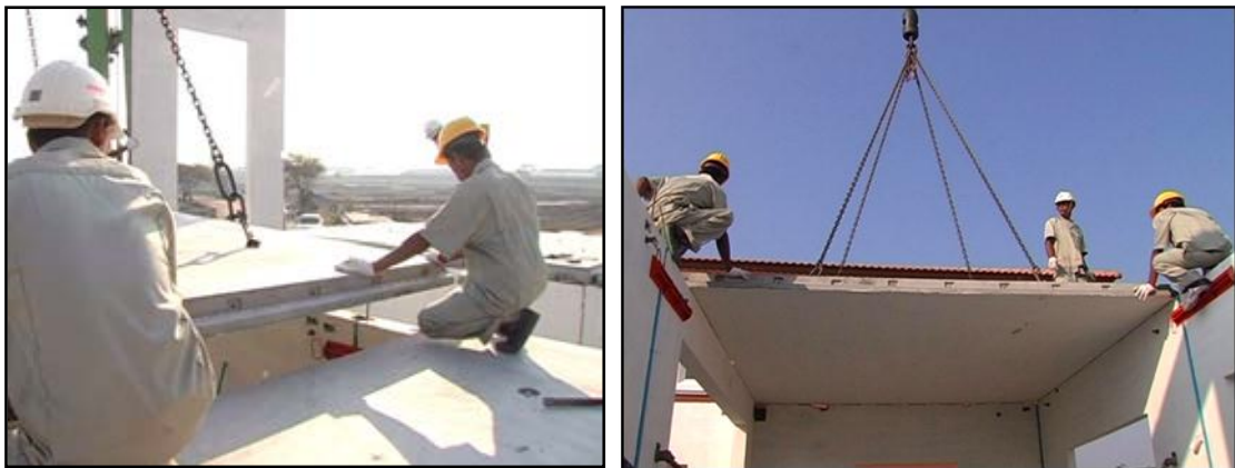
ภาพที่ 3. 20 การติดตั้งพื้นชั้นบน
