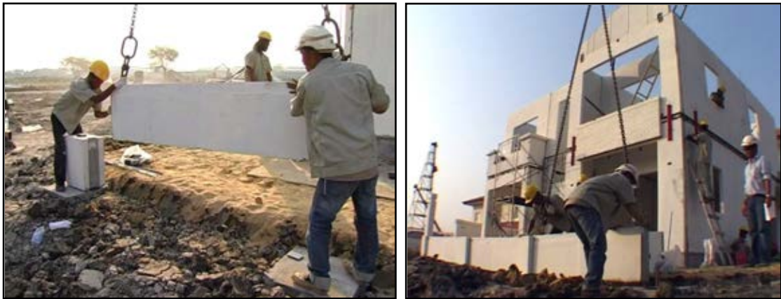
ภาพที่ 3. 23 การติดตั้งรั้วข้างบ้านและหน้าบ้าน
