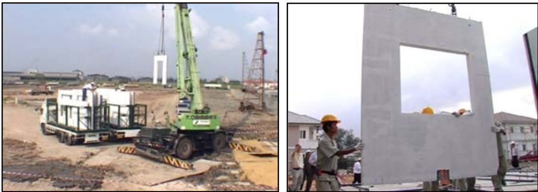
ภาพที่ 3.17 การติดตั้งผนังชั้นล่าง
