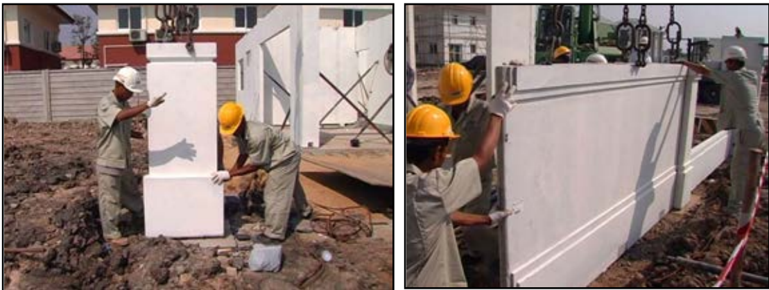
ภาพที่ 3.18 การติดตั้งรั้วข้างบ้าน
