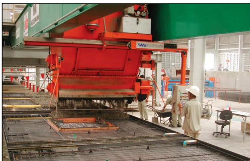
ภาพที่ 3. 9 กระจายบรรจุคอนกรีตรับคอนกรีตผสมเสร็จมาเทลงในเครื่องเทคอนกรีต
