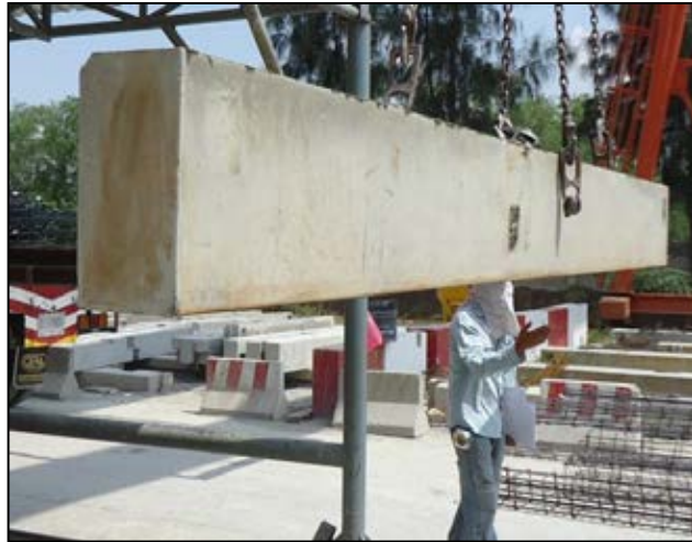
ภาพที่ 3. 19 การติดตั้งคาน
