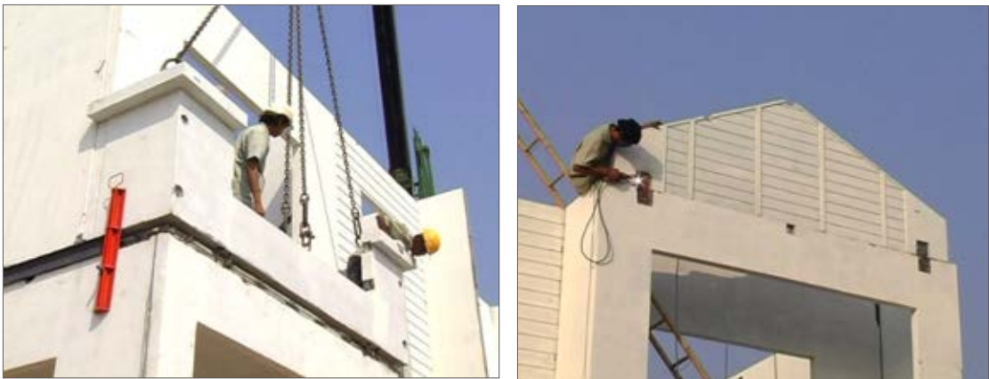
ภาพที่ 3. 22 การติดตั้งซันตกแต่งสำเร็จรูป
