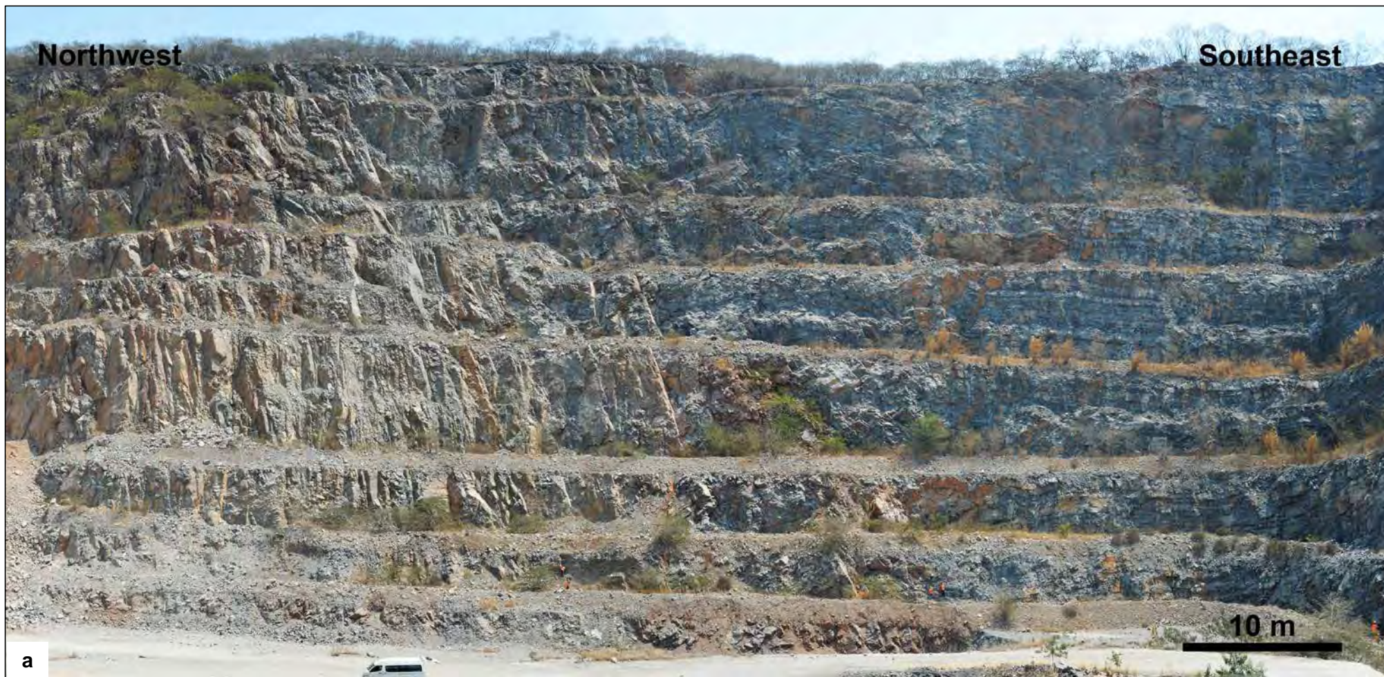
รูปที่ 4.21 (a) หินโคลงบริเวณ C ที่มีรอยเลื่อนตัดผ่านทำให้เกิดรอยชั้นไม่ต่อเนื่องของหินปูนสองชนิด
