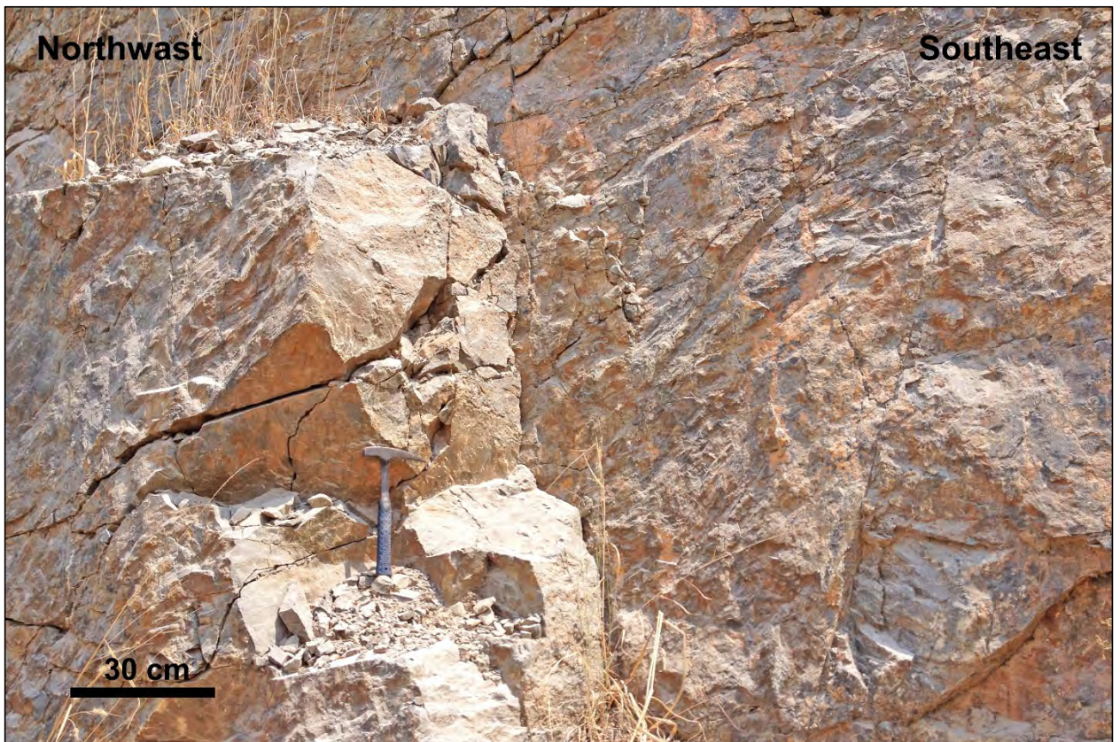
รูปที่ 4.28 ระบายรอยแตกที่มีการวางตัวตั้งฉากกับรอยเลื่อนหลักในพื้นที่ ซึ่งมีระบายรอยแตก 150^{\circ}/85^{\circ}\text{SW} โดยจะสังเกตเห็นได้ชัดเจนในหน้าเหมืองของรอยแตกที่มีการเอียงเทไปทางทิศตะวันตก
