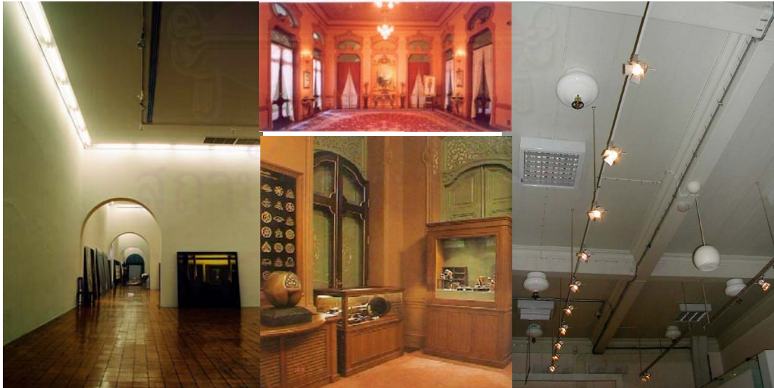
ภาพที่ 3-34 ไฟฟ้าแสงสว่างภายใน พิพิธภัณฑ์สถานแห่งชาติ หอศิลป์
