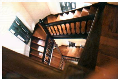
ภาพที่ 3-55 ภาพแสดงบันไดปีกข้างอาคารหลังการบูรณะ ก่อนติดตั้งลิฟท์โดยสารพิพิธภัณฑทร์พระบาทสมเด็จพระปกเกล้าเจ้าอยู่หัว
