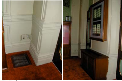
ภาพที่ 3-40 หน้ากากดูดลมกลับ และตู้ครอบเครื่องจ่ายลมเย็นจากใต้พื้นชั้น 1 พิพิธภัณฑสถานแห่งชาติประเทศไทย
