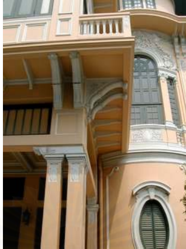
ภาพที่ 3-11 ภาพแสดงครีบกั้นสาดของวังบางขุนพรหมที่พบการเสริมเหล็กภายในโครงสร้าง
