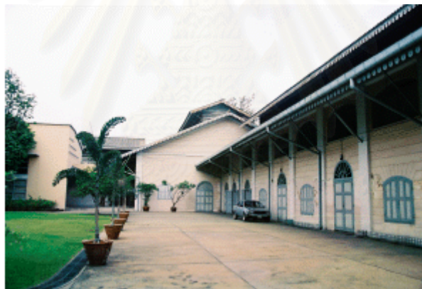
ภาพที่ 3-13 ภาพแสดงการอาคารโรงหล่อด้านหลังเป็นหลังคาจั่วที่มีการยกชั้นหลังคาเพื่อกา ระบายอากาศ
