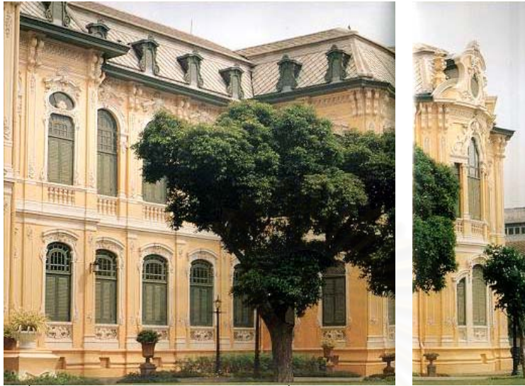
ภาพที่ 3-14 ภาพแสดงการหลังคาทรงสูงที่มีหน้าต่าง (Dormer Window) อยู่ตลอดแนวหลังคาทั้งสองด้าน เพื่อให้ลมพัดผ่านระบายอากาศ
