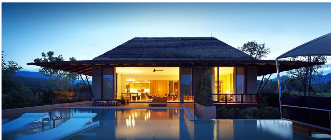
รูปที่ 68 โครงการคิริมายาเรสซิเดนส์ (Kirimay Residences)
