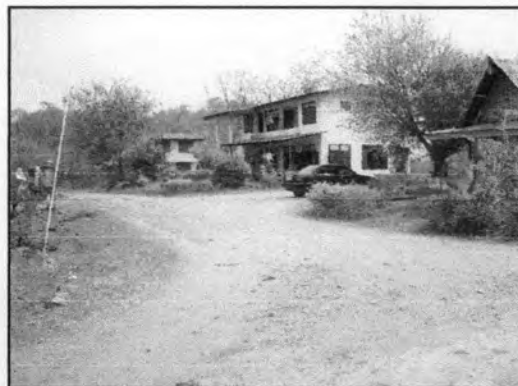
ภาพที่ 4.9 ถนนดินจากทางเข้าสู่ตัวอาคาร
