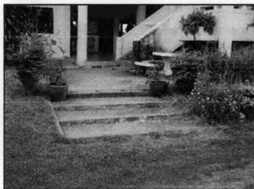
ภาพที่ 4.6 บันไดภายนอกอาคาร
