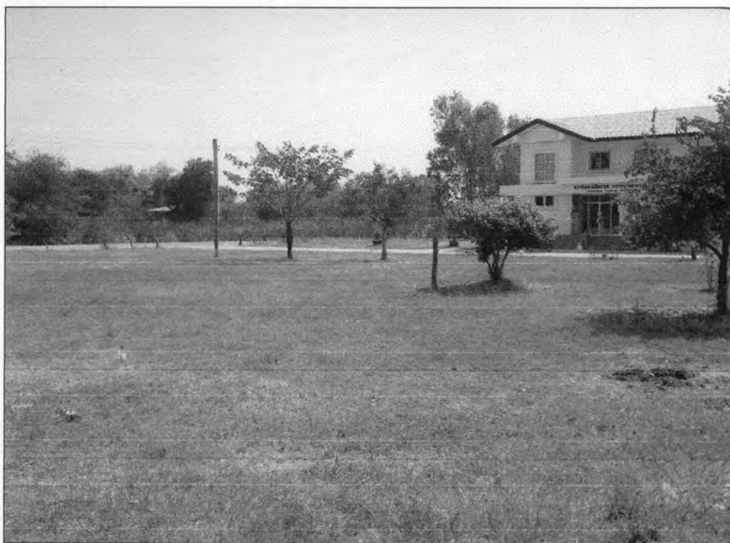
ภาพที่ 4.53 มุมมองภายนอกอาคารสถานีอนามัยมะรุุม
