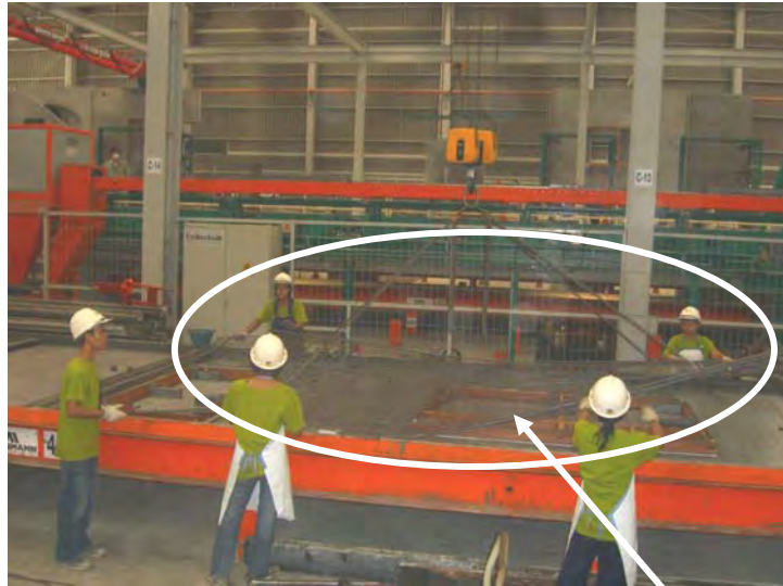
วางคอนกรีตเสริมความแข็งแรง
