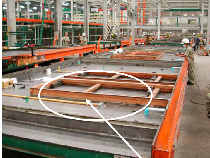
ติดตั้งประตู
