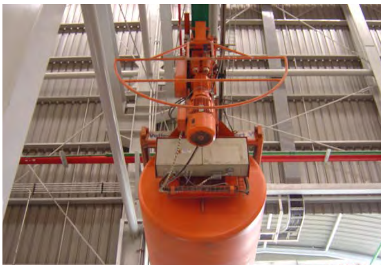
รูปที่ 3.10 ชั้นตอมลำเลียงคอนกรีต
