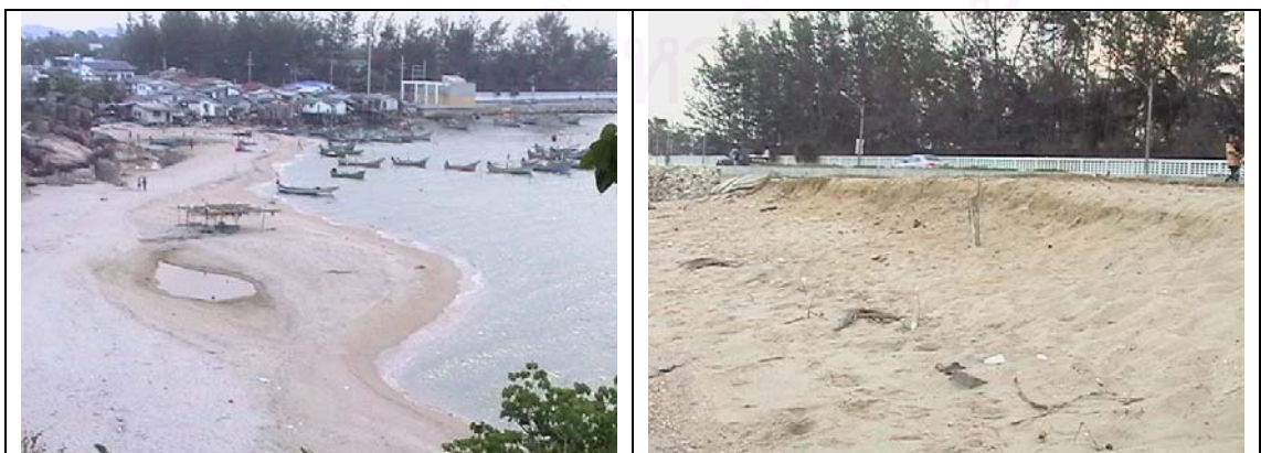
รูป ก.1-5 ชายฝั่งบริเวณแหลมแก้วเสด็จ (SK5)
