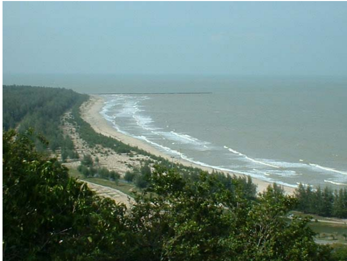
รูป ก.2-4 คลื่นบริเวณเขื่อนดักตะกอน
