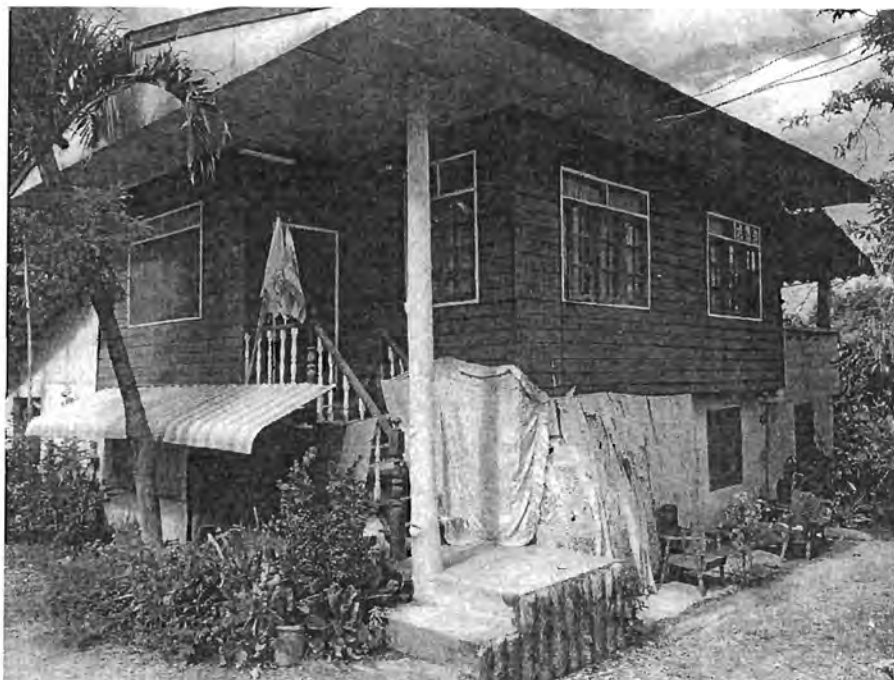
ภาพที่ 4.4 บ้านพักอาศัย บ้านห้วยหวาย ตำบลดงมะตะ อำเภอแม่ลาว จังหวัดเชียงราย
